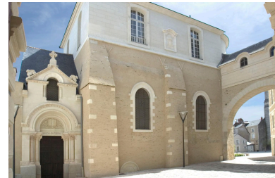
Chapelle saint-Eloi. Elévation extérieure sud après restauration.
