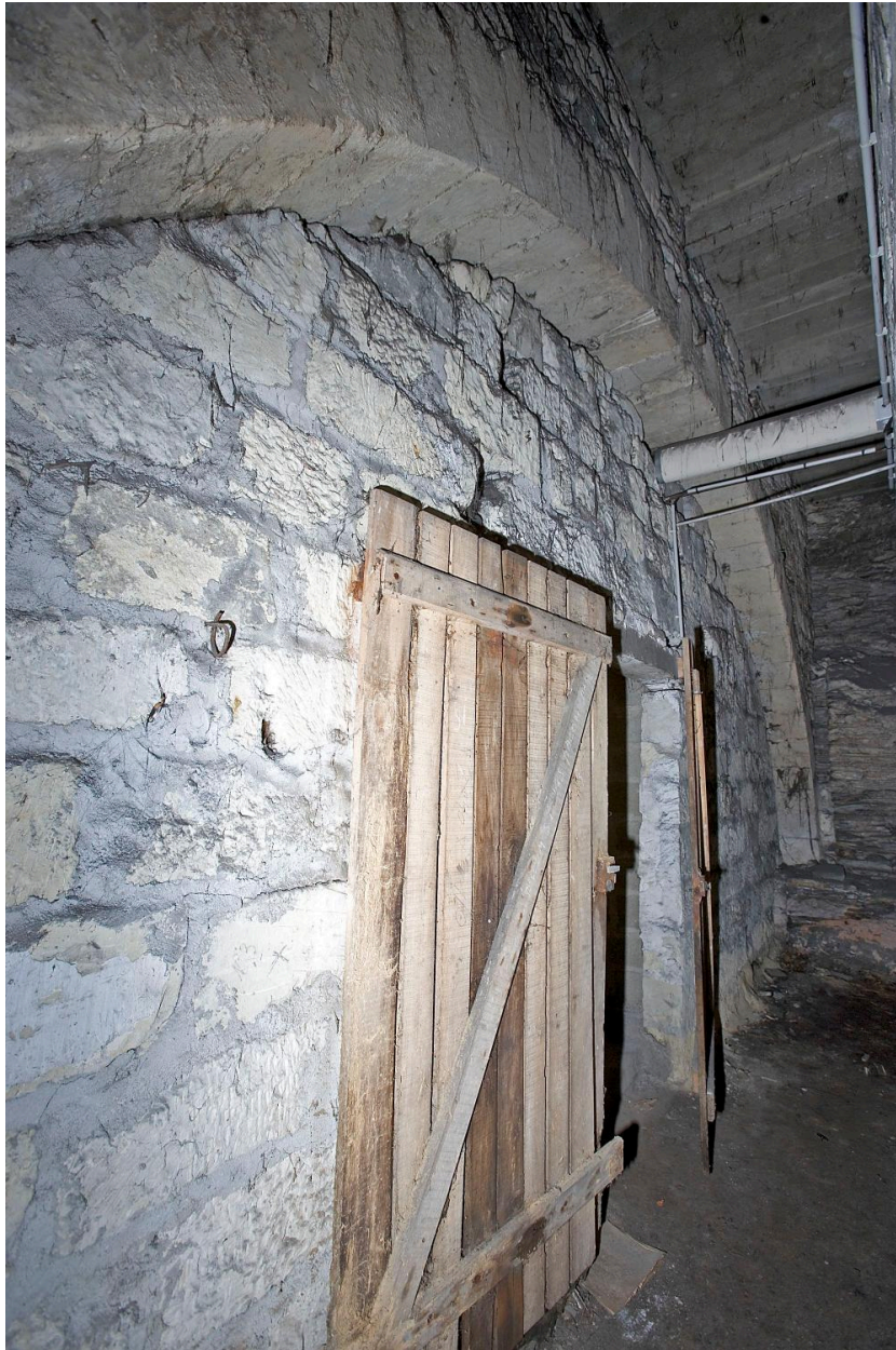
Corps de bâtiment du petit séminaire, sous-sol : caves 5 et 7, arc-diaphragme, avec en-dessous, une paroi mince moderne de délimitation des caves actuelles (caves 3 et 4 de l'autre côté de ce mur).
