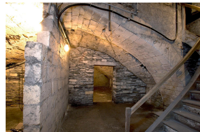
Corps de bâtiment du petit séminaire, sous-sol : cave 2, vue d'ensemble, avec les faces latérale gauche et postérieure ; au premier plan, un arc-diaphragme. A droite, descente d'escalier moderne.
