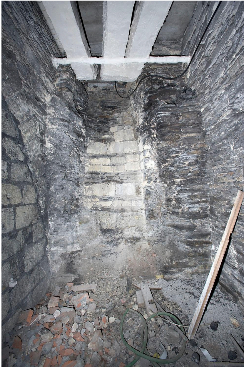
Corps de bâtiment du petit séminaire, sous-sol : cave 3, face antérieure, maçonneries de schiste en avancée d'usage indéterminé ; à gauche, départ d'un arc-diaphragme se poursuivant dans la cave 4.
