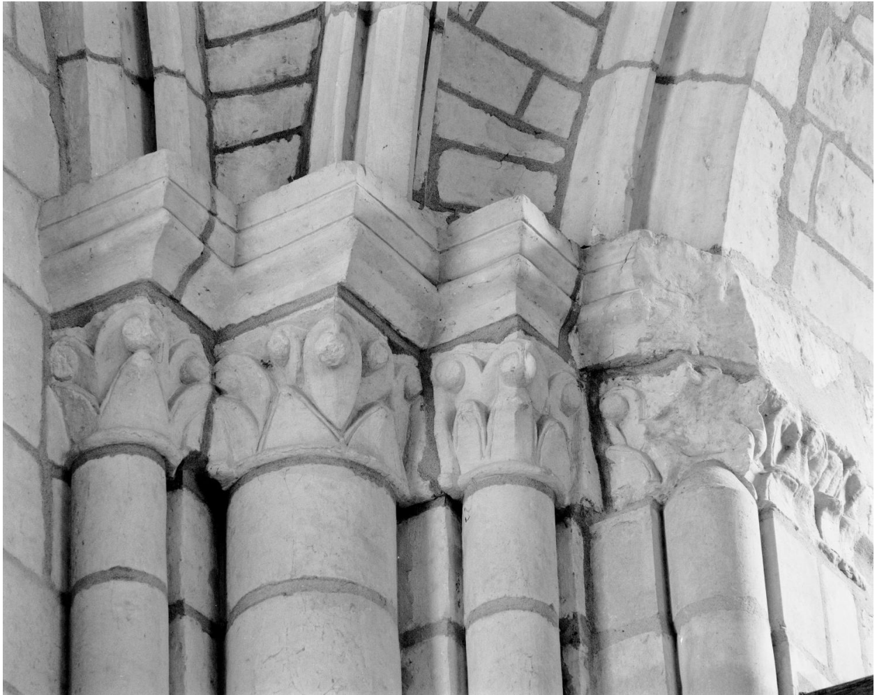
Eglise, première travée de la nef, pile sud-ouest : frise de chapiteaux.
