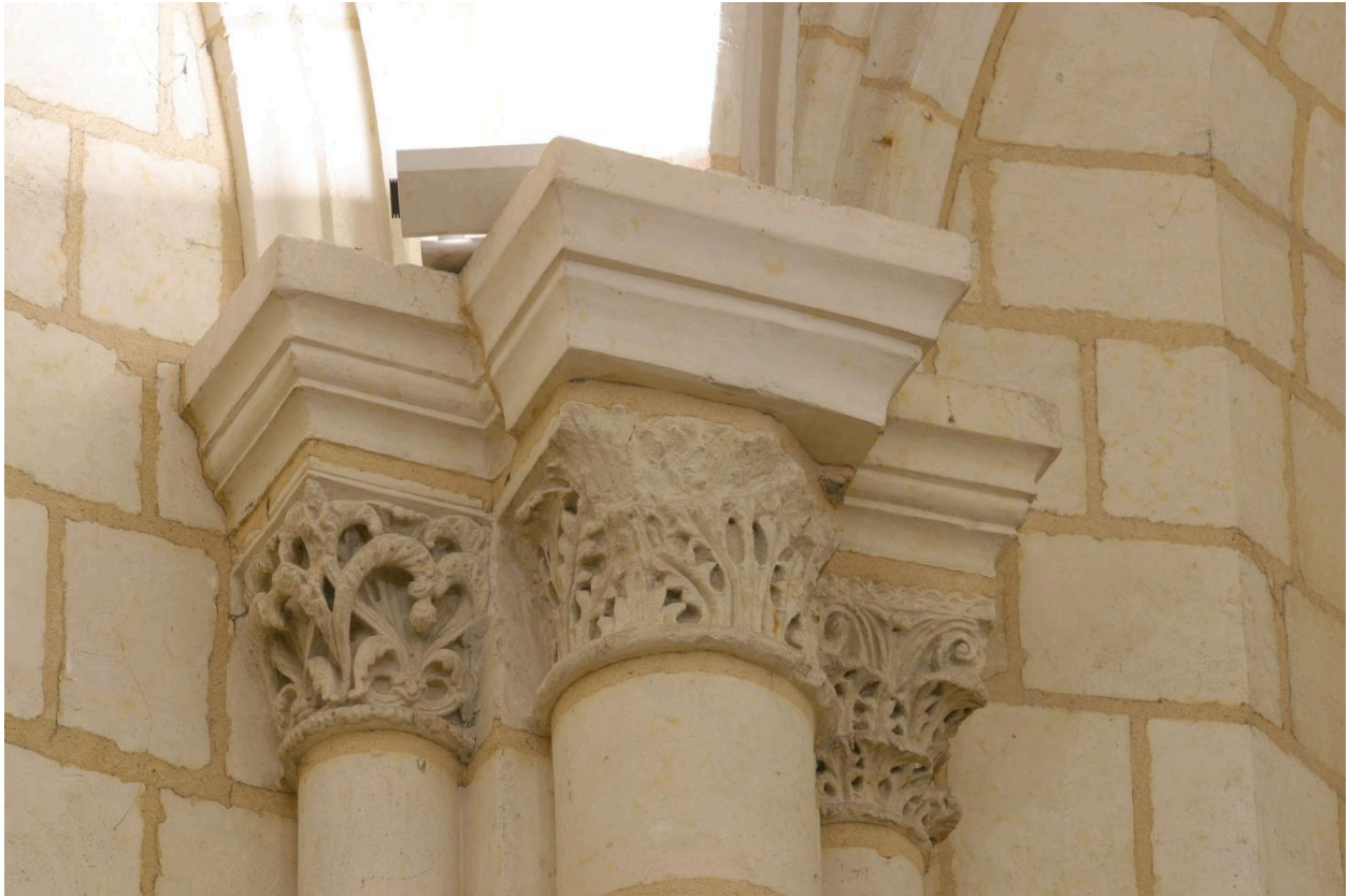
Chapelle Saint-Eloi. Abside : groupe de chapiteaux à feuillage à gauche de la baie axiale : vue d'ensemble.
