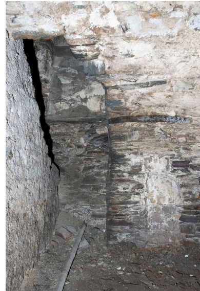
Corps de bâtiment du petit séminaire, sous-sol : cave 1, angle postérieur gauche, ouverture sur la cave d'un puits.
