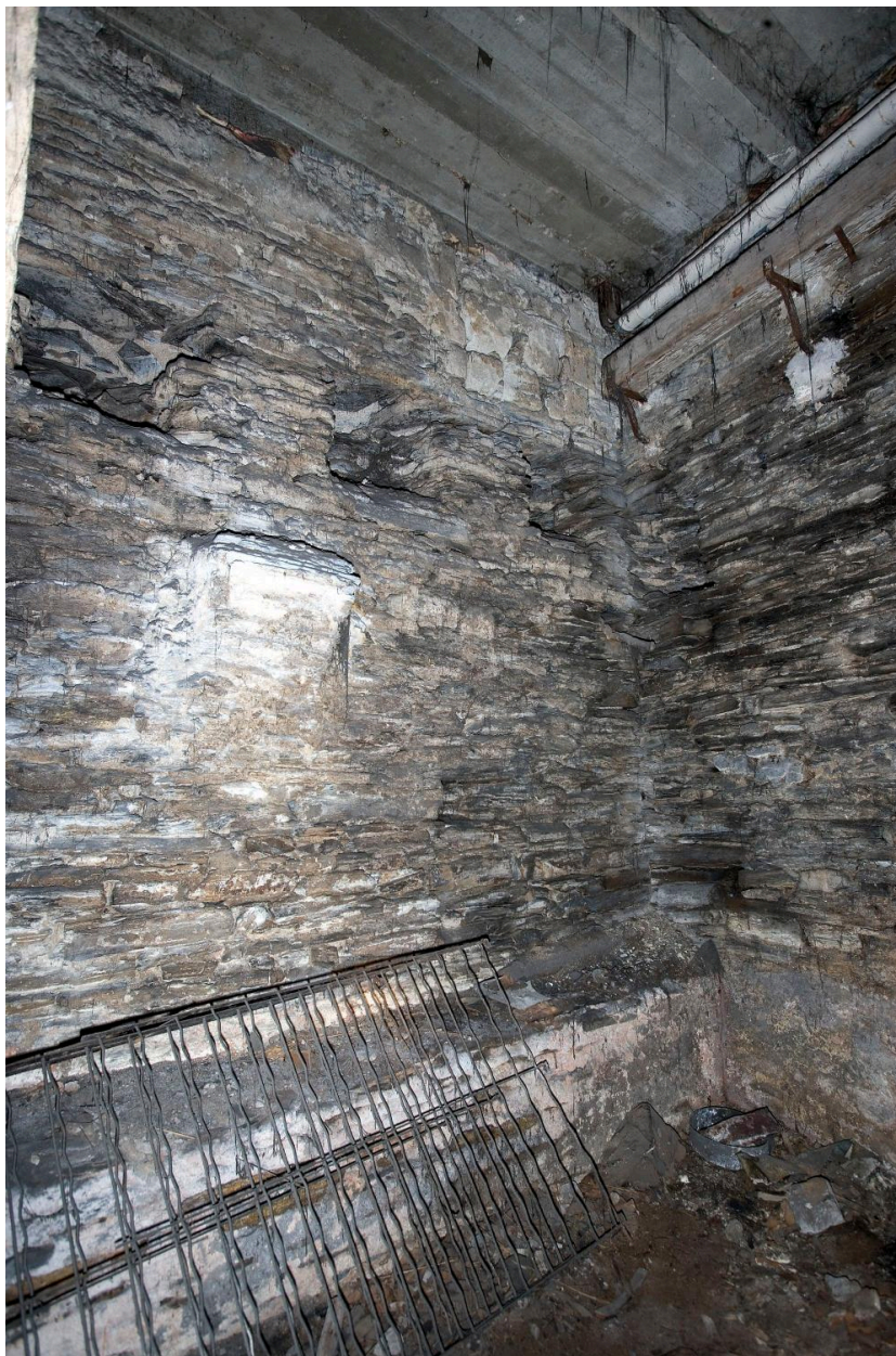
Bâtiment du petit séminaire, sous-sol : cave 7, angle postérieur droit, avec au premier plan un corbeau en moellon de schiste (support de poutre d'un ancien plafond ?) ; en partie haute, sous le plafond, vestiges d'une ouverture murée.
