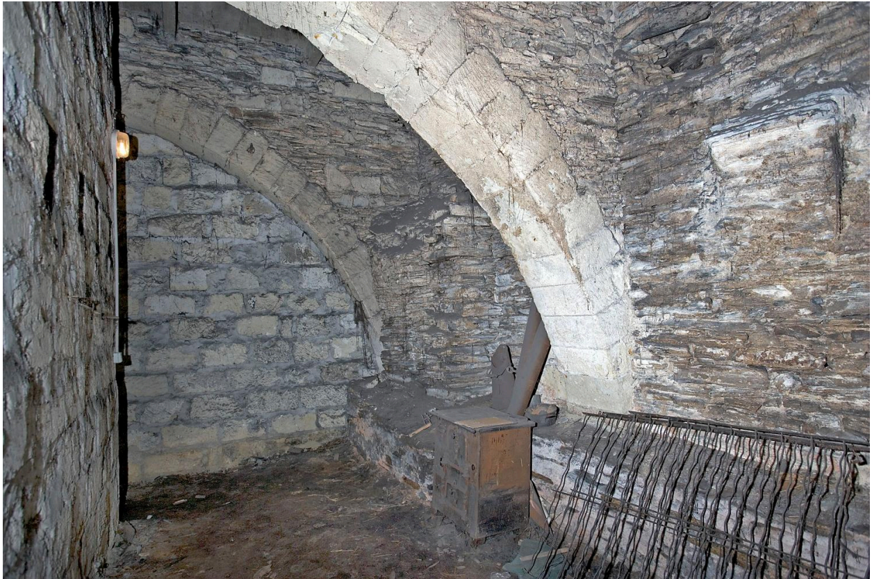
Bâtiment du petit séminaire, sous-sol : cave 7, faces gauche et postérieure, avec les arcs-diaphragmes vers les caves 5 et 6 ; au 1er plan, corbeau en moellon de schiste (support de poutres d'un ancien plancher ?).
