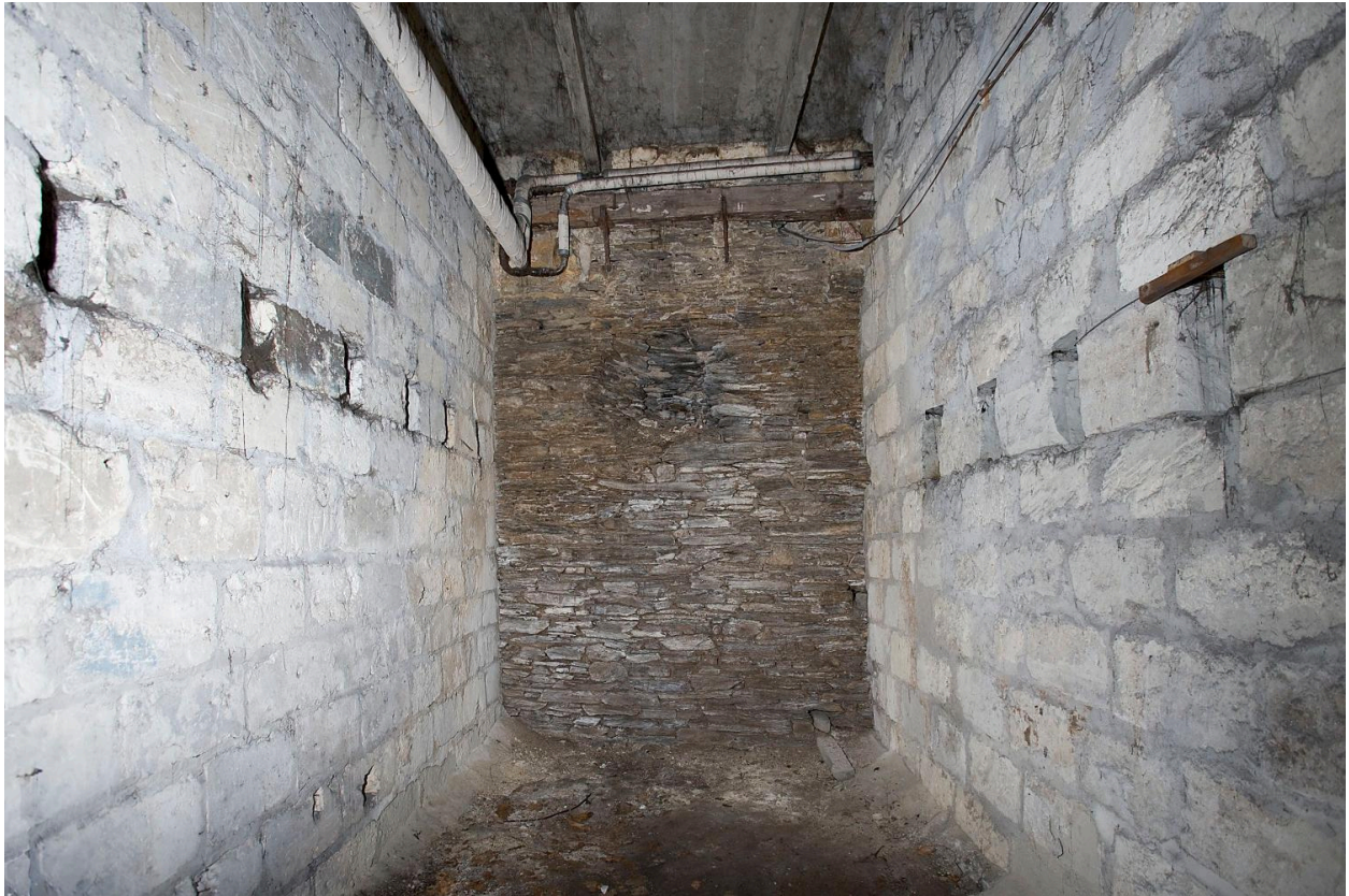
Corps de bâtiment du petit séminaire, sous-sol : cave 6, vue d'ensemble, avec les faces antérieure et postérieure en murs minces de tuffeau ; en fond, la face latérale droite qui correspond au mur-pignon droit de l'édifice.
