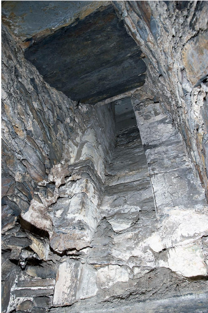
Corps de bâtiment du petit séminaire, sous-sol : cave 1, angle antérieur gauche, soupirail, vue en contre-plongée.
