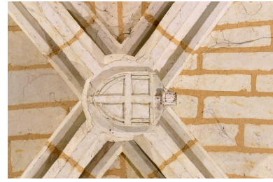
Chapelle Saint-Eloi. Première travée : clef de voûte armoriée. Phot. François Lasa IVR52_20044900511NUCA
