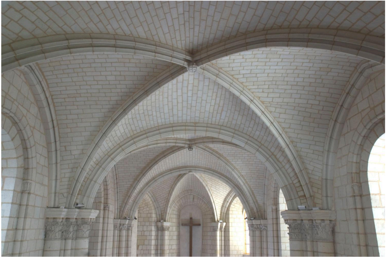
Chapelle saint-Eloi. Nef, détail sur les voutes, depuis le haut de la tribune.
