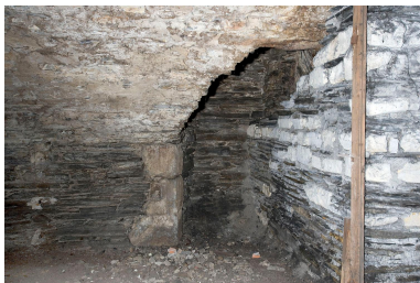
Corps de bâtiment du petit séminaire, sous-sol : cave 1, angle postérieur droit, partie basse de soupirail.
