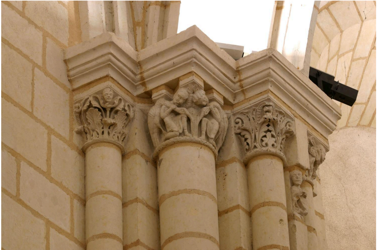
Chapelle Saint-Eloi. Groupe de chapiteaux à l'entrée nord-ouest du chœur, face sud-ouest : personnages affrontés avec échassiers et en contrebas du chapiteau, petite figure de saint Eloi.
