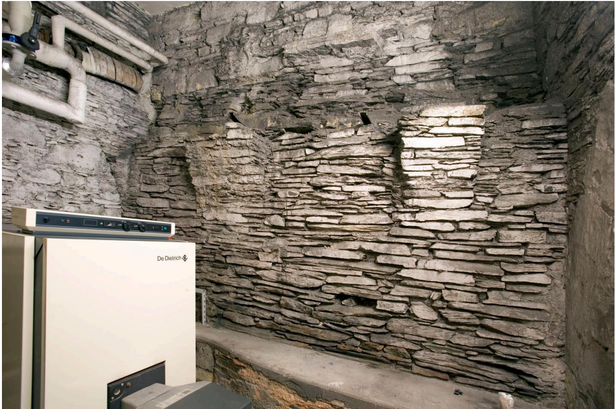
Corps de bâtiment du petit séminaire, sous-sol : cave 4, face postérieure, avec corbeaux en moellon de schiste (support de poutres d'un ancien plancher ?).
