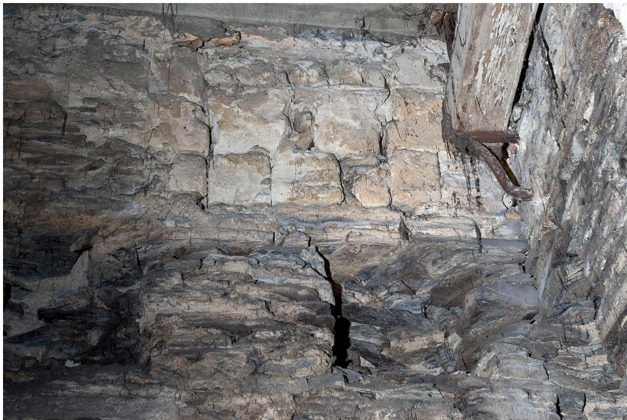
Corps de bâtiment du petit séminaire, sous-sol : cave 7, face postérieure, angle postérieur droit, détail sur une ouverture murée.
