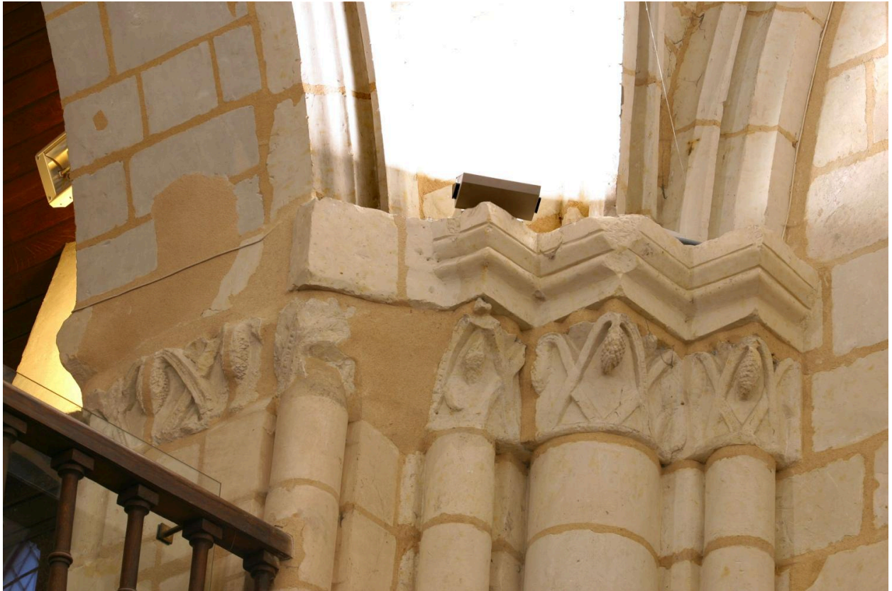
Chapelle Saint-Eloi. Première travée, pile nord-ouest : groupe de chapiteaux en entrant à gauche.
