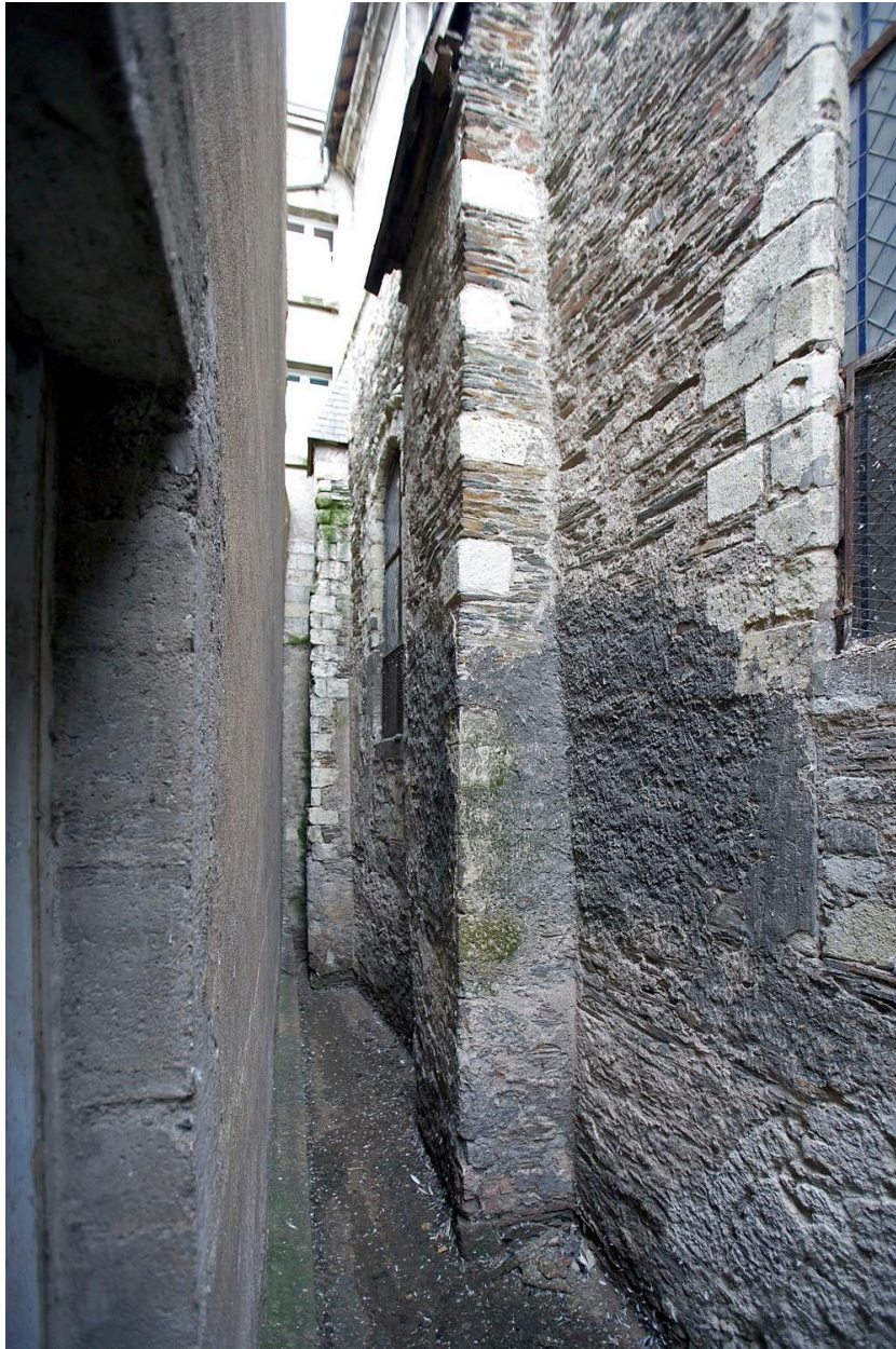
Eglise Saint-Eloi : élévation latérale nord, vue en tangente depuis l'ouest.
