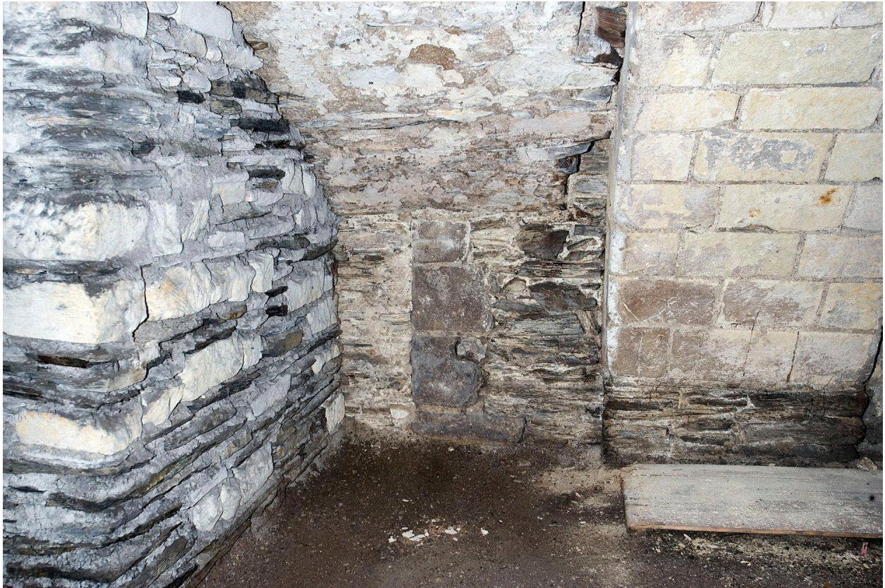
Corps de bâtiment du petit séminaire, sous-sol : cave 2, angle postérieur gauche, piédroit droit d'un soupirail en partie obturé ; à droite, front d'un arc-diaphragme. A gauche, mur de séparation d'avec la cave 1.
