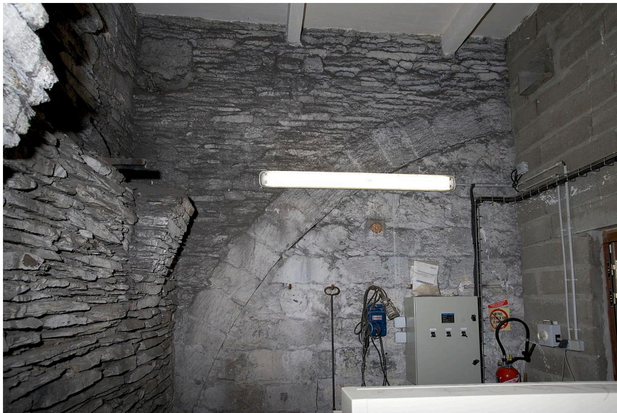
Corps de bâtiment du petit séminaire, sous-sol : cave 4, face latérale droite avec face latérale d'un arc-diaphragme commençant dans la cave 3 ; à gauche, corbeaux en moellon de schiste (support de poutres d'un ancien plancher ?).
