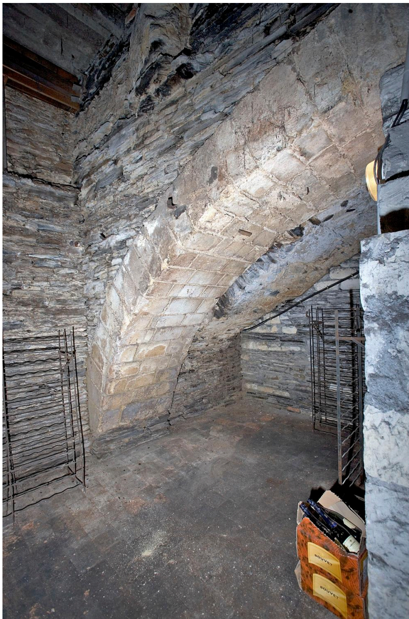
Corps de bâtiment du petit séminaire, sous-sol : cave 2, partie antérieure, face antérieure avec départ d'un arc-diaphragme.
