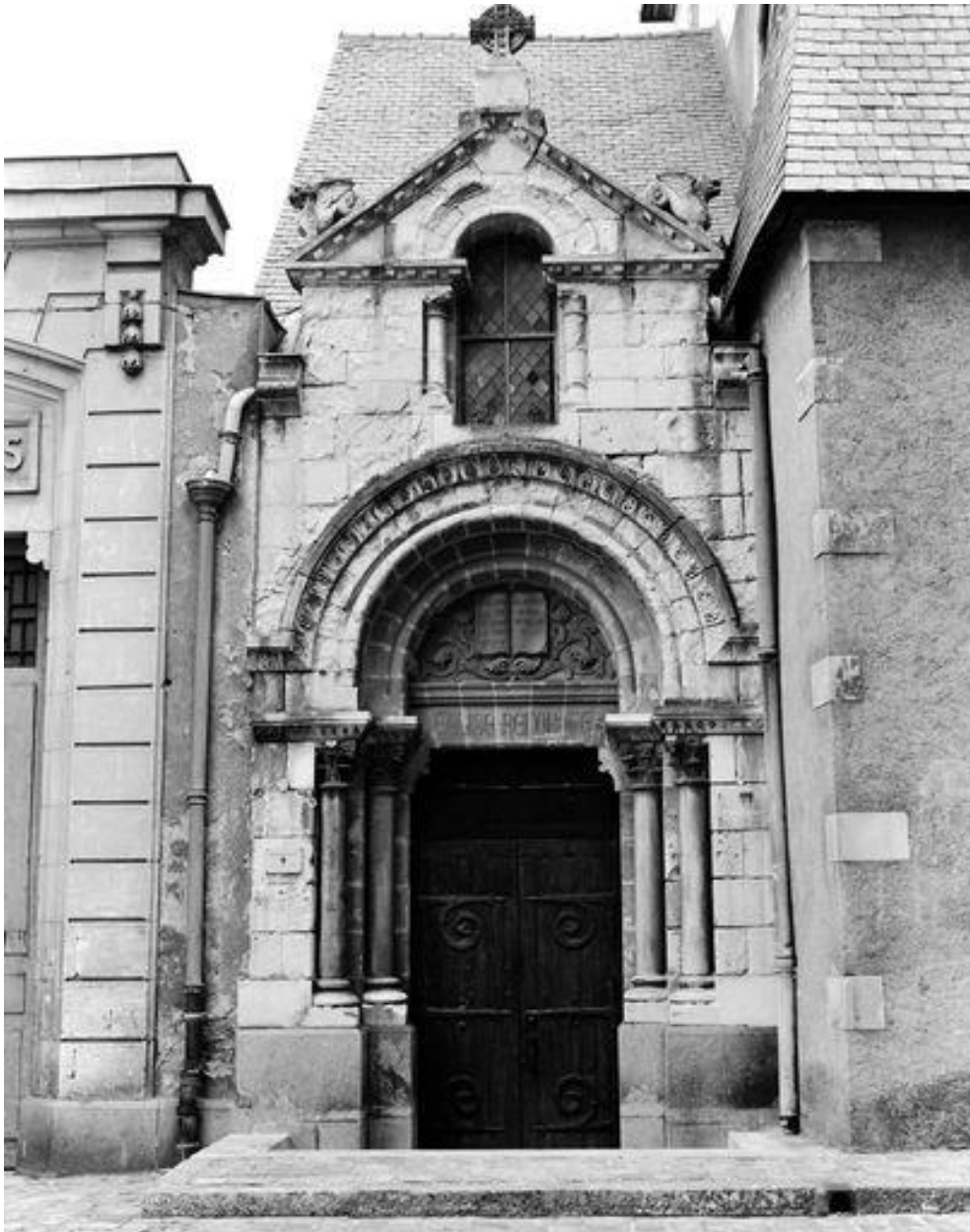
Eglise, le porche : façade sur rue.
