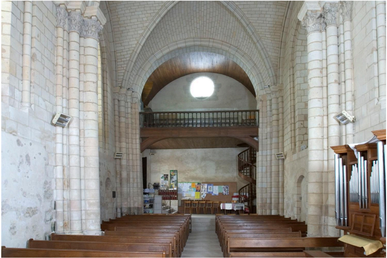
Chapelle Saint-Eloi. Nef, vue intérieure vers le vestibule et la tribune.
