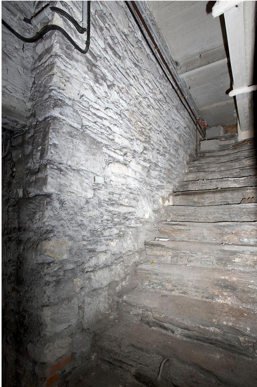
Corps de bâtiment du petit séminaire, sous-sol : escalier droit de descente de cave directement accessible de l'extérieur, entre les caves 2 et 3.
