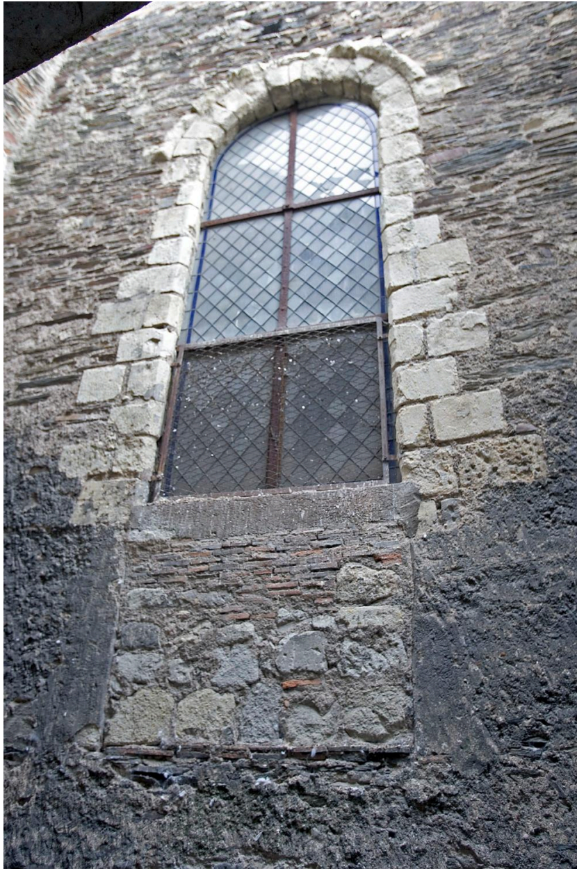
Eglise Saint-Eloi, élévation latérale nord, première travée : baie.
