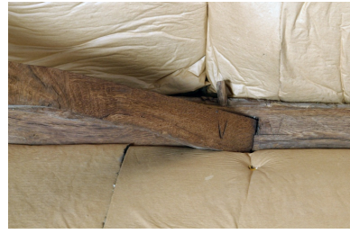
Charpente du bâtiment perpendiculaire à la rue, détail de marques d'assemblage. Phot. Denis Pillet IVR52_20074400946NUCA
