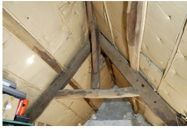
Charpente du bâtiment perpendiculaire à la rue. Phot. Denis Pillet IVR52_20074400945NUCA
