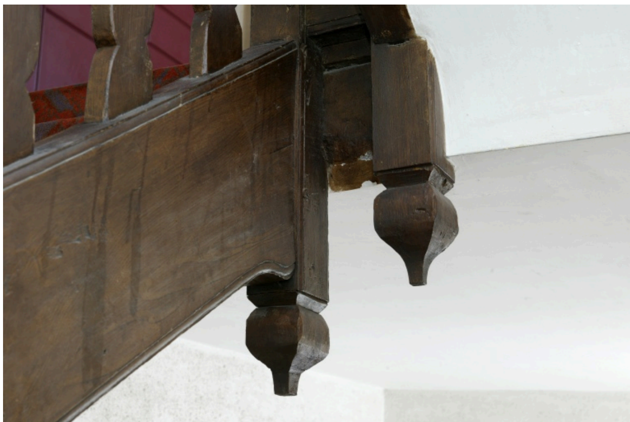
Détail des poinçons de l'escalier.
