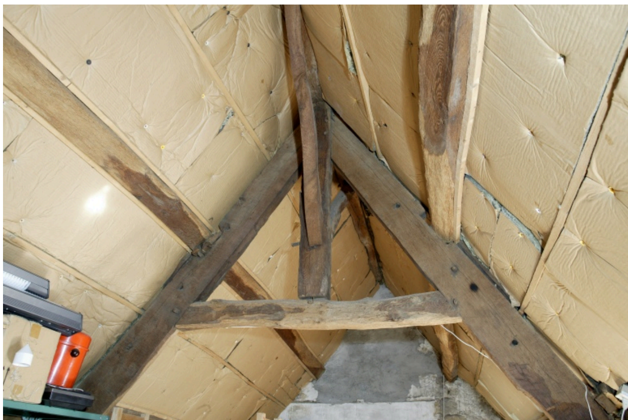
Charpente du bâtiment perpendiculaire à la rue.
