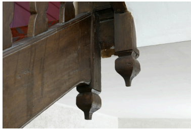
Détail des poinçons de l'escalier. Phot. Denis Pillet IVR52_20074400947NUCA
