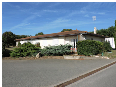
Ancien bâtiment de bureaux, à l'ouest de la rue, vu depuis le sud-est, démolé en 2020. Phot. Yannis Suire IVR52_20198503214NUCA
