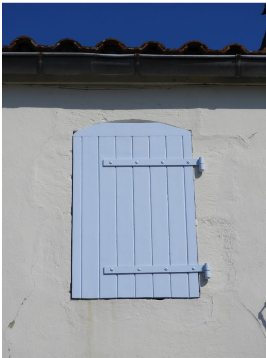
Une des baies avec linteau en arc segmentaire.
