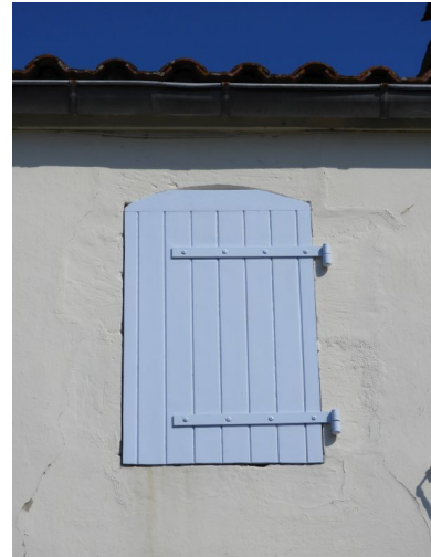
Une des baies avec linteau en arc segmentaire.
