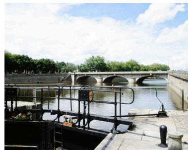
Vue d'ensemble depuis le sud. Phot. François Lasa IVR52_19885300329XA
