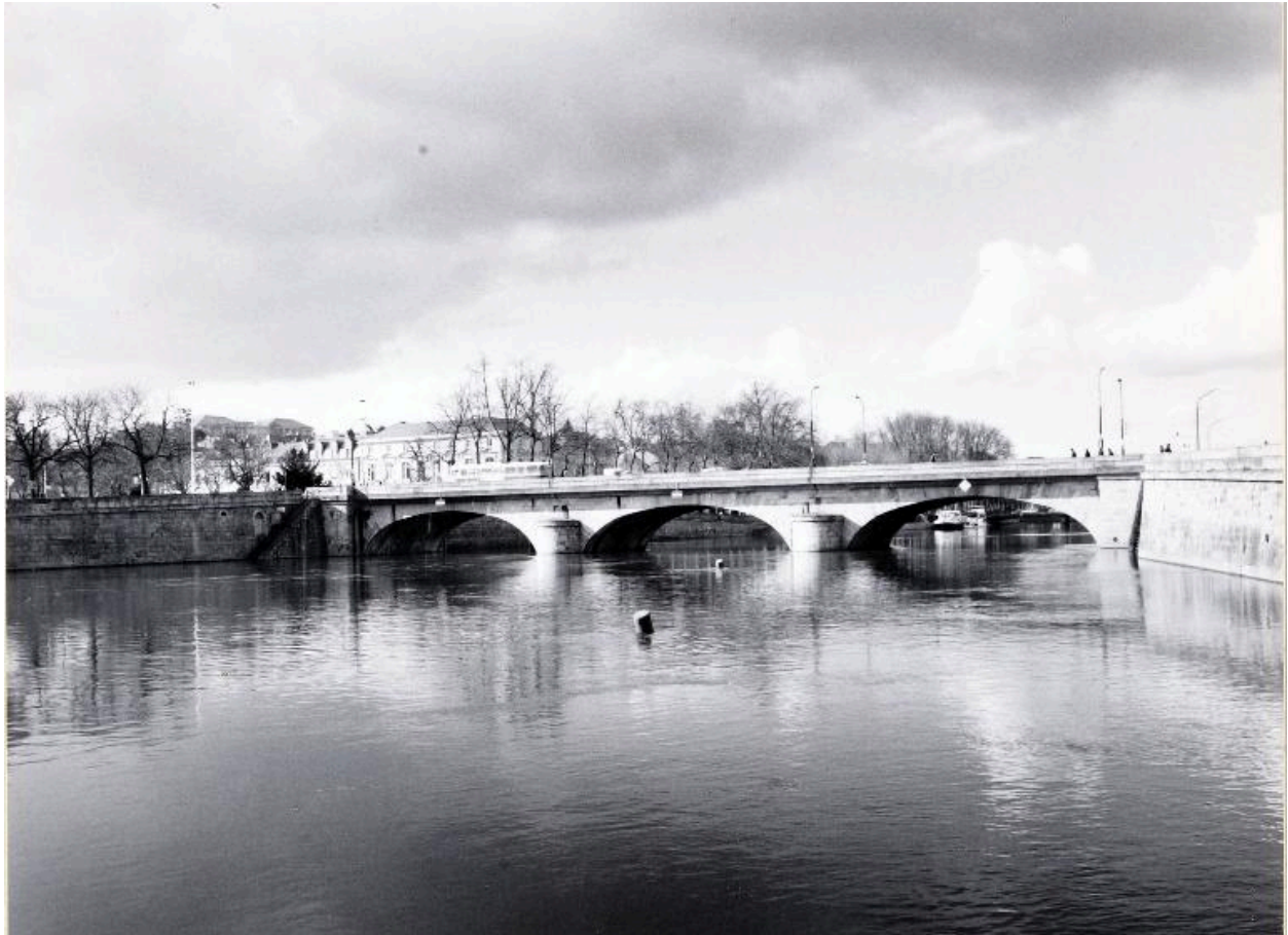
Pont Aristide Briand : vue prise côté sud.
