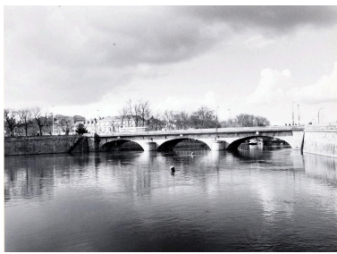
Pont Aristide Briand : vue prise côté sud. Phot. François Lasa IVR52_19845300469X
