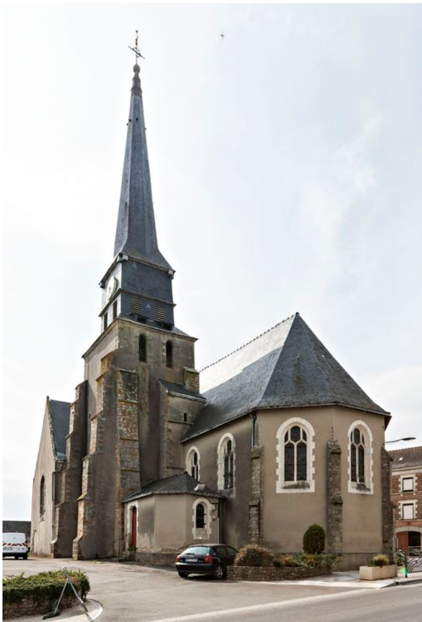
Vue d'ensemble de l'église depuis le nord-ouest.
