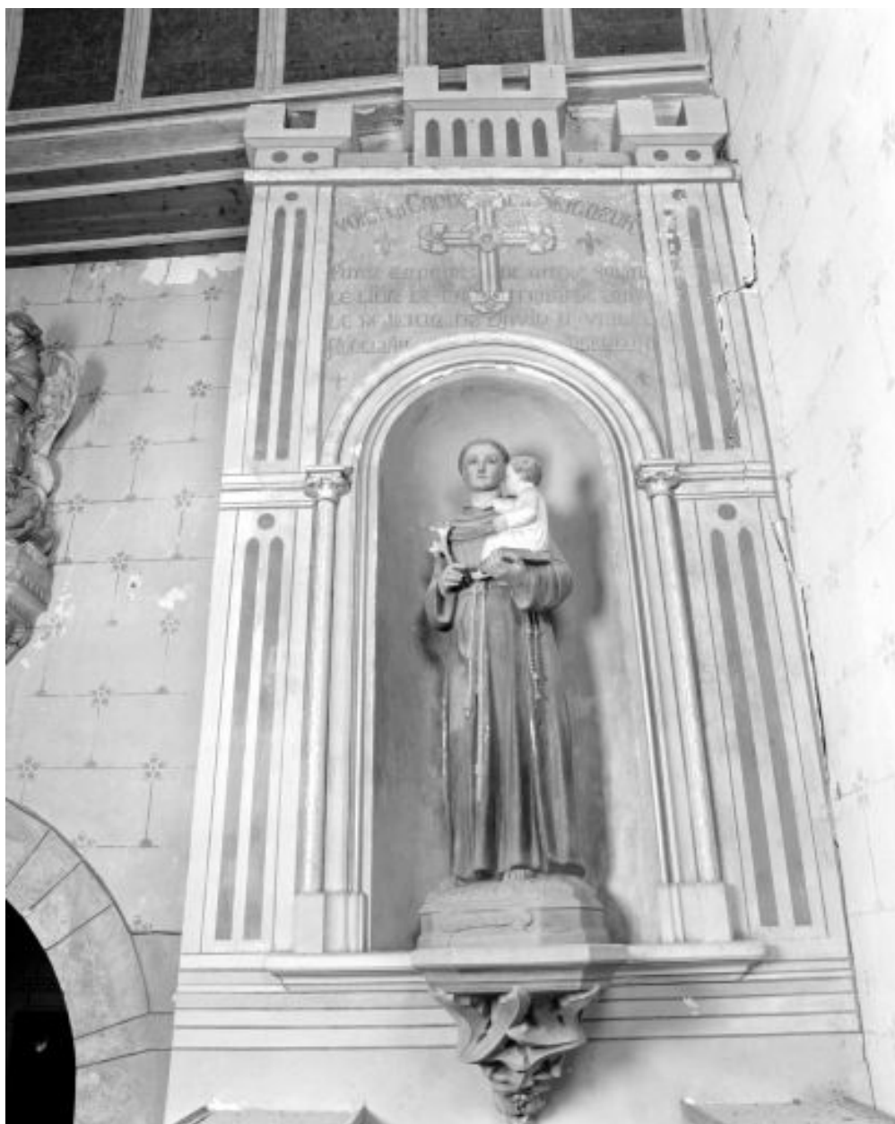
Le mur est du bras sud du transept, avec son décor peint par Ladislav Dymkowski.
