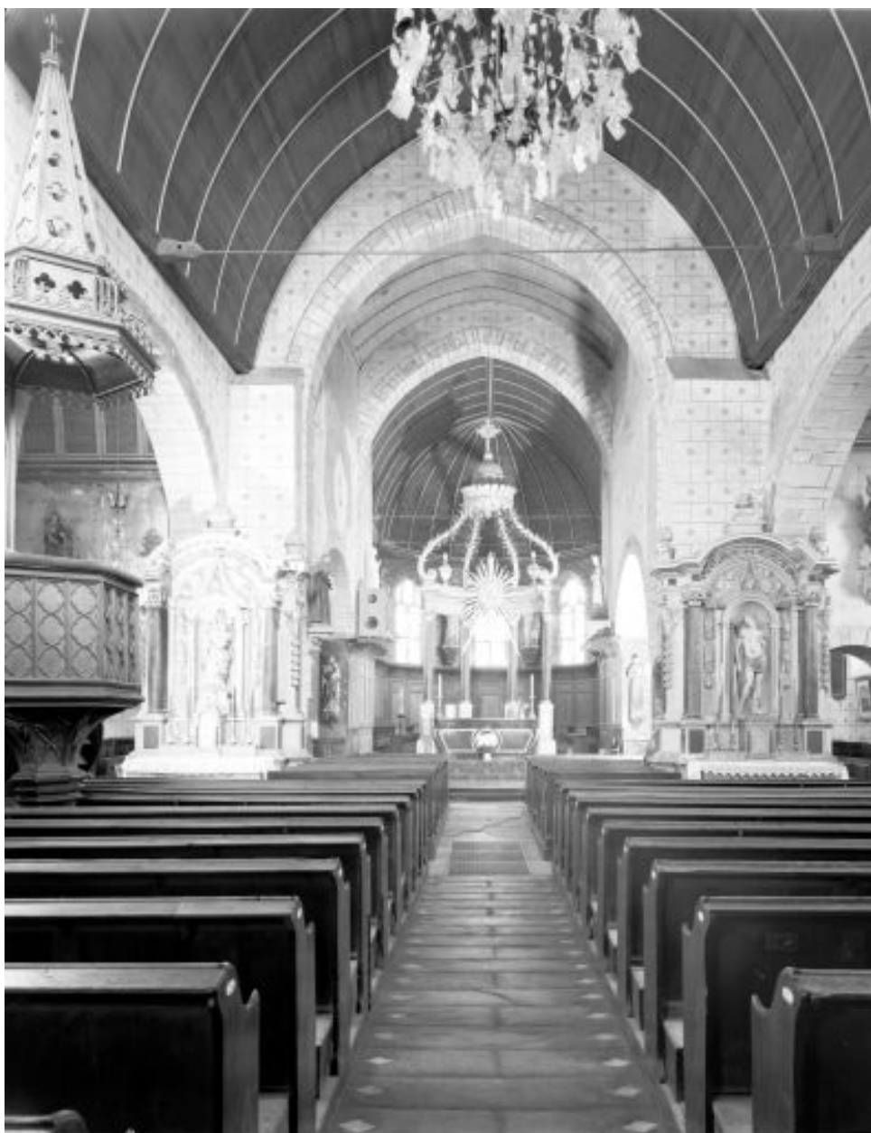
Le chœur vu depuis la nef.
