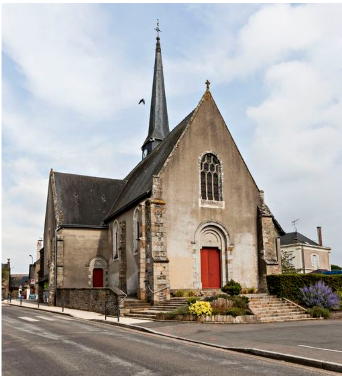
Vue d'ensemble de l'église depuis le sud-est.
