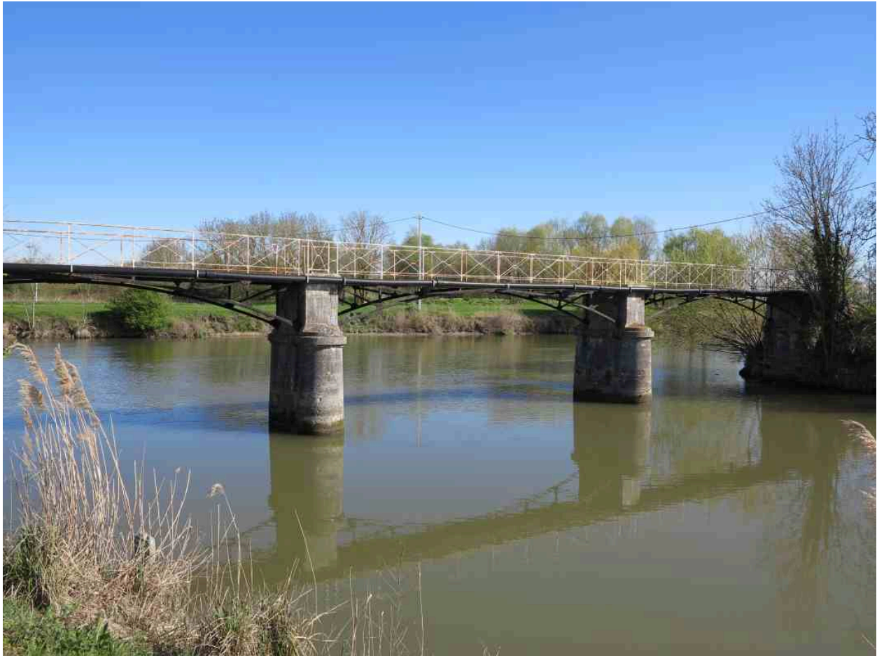
La passerelle vue depuis l'amont, au sud.
