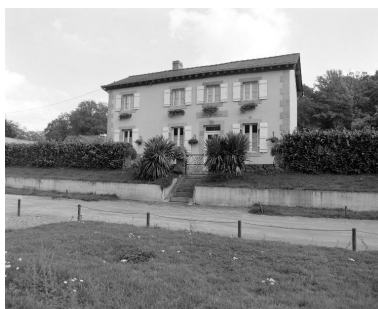
La maison éclusière. Phot. François Lasa IVR52_20015300460X
