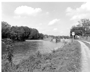
Vue d'ensemble du site d'écluse depuis l'aval : barrage, centrale hydroélectrique, écluse, transformateur électrique. Phot. François Lasa IVR52_20015300459X
