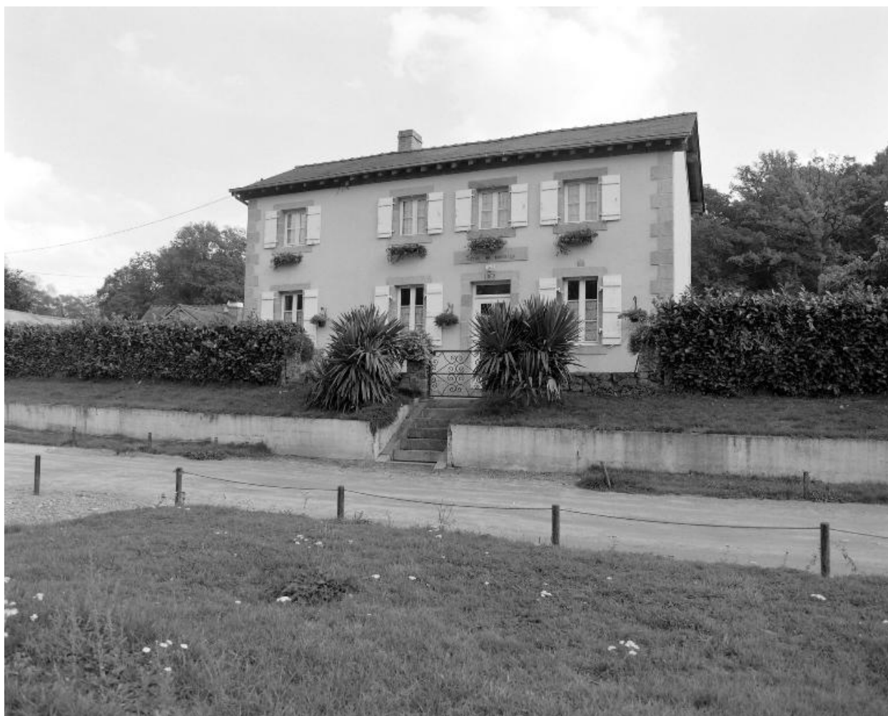
La maison éclusière.
