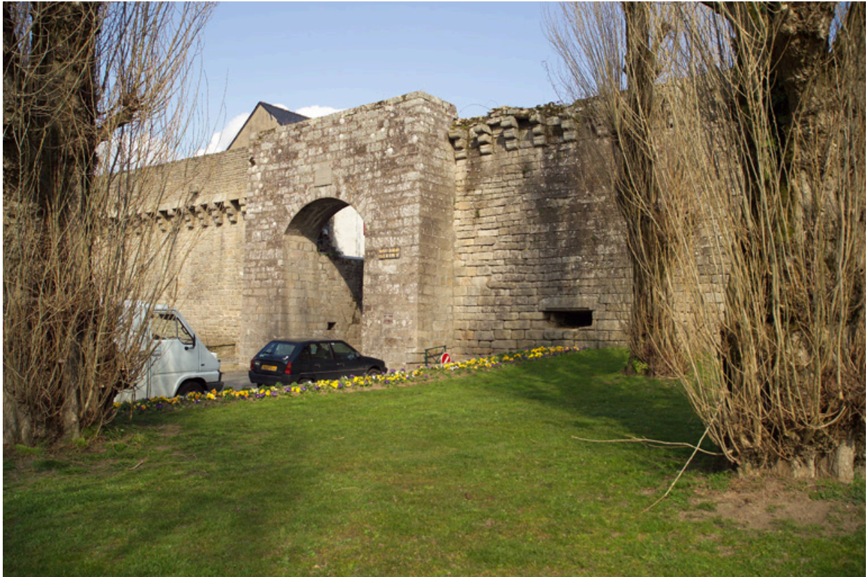
Vue générale vers le Nord-Est.
