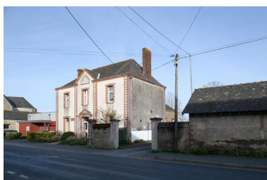
Vue d'ensemble depuis le sud. Phot. Armelle Maugin IVR52_20244900442NUCA
