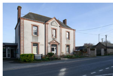
Vue d'ensemble depuis le nord. Phot. Armelle Maugin IVR52_20244900439NUCA
