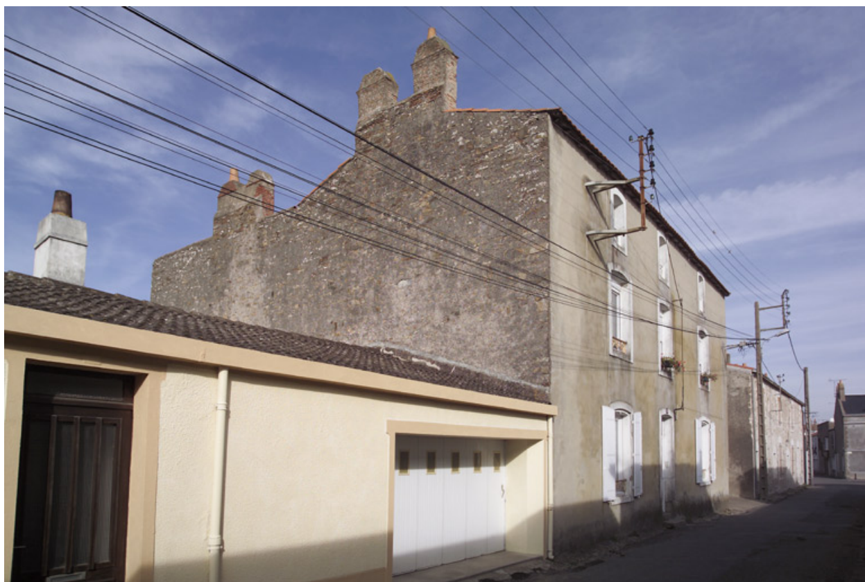
Maison, 16 rue de l'Hôpital.
