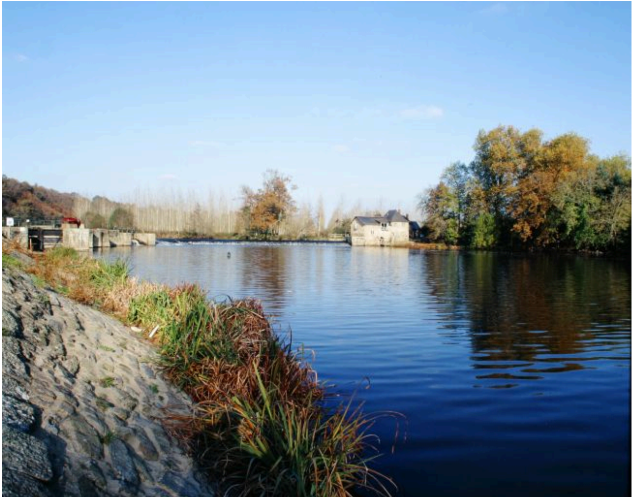
Vue d'ensemble du site depuis la cale de débarquement située rive droite en aval : écluse, soubassement du moulin détruit, barrage, moulin situé rive gauche à Azé.
