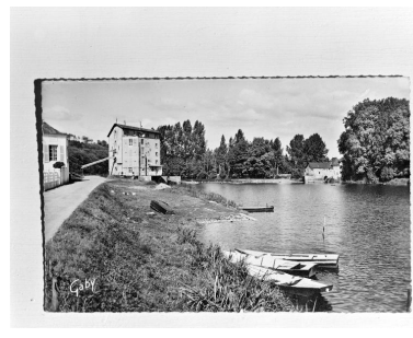
Vue d'ensemble du site depuis la rive droite en aval : le barrage et les deux moulins de Mirvault. Phot. Gabriel Artaud, Repro. François Lasa IVR52_20025300803X
