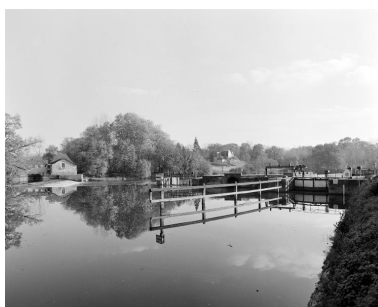
Vue d'ensemble du site depuis la rive droite en amont : moulin situé rive gauche à Azé, barrage, pertuis, soubassement du moulin détruit, écluse. Phot. François Lasa IVR52_20015300646X
