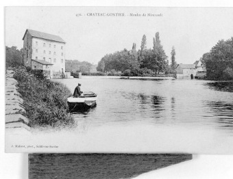
Vue d'ensemble du site depuis la cale située rive droite, en aval : le pertuis, le barrage et les deux moulins de Mirvault. Autr. J. Malicot, Repro. François Lasa IVR52_20015300338X
