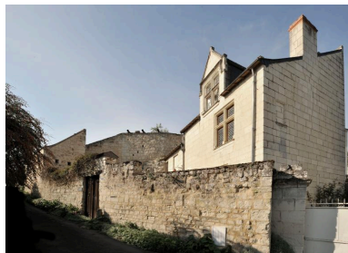
Vue sur l'ancien logis depuis la rue.
