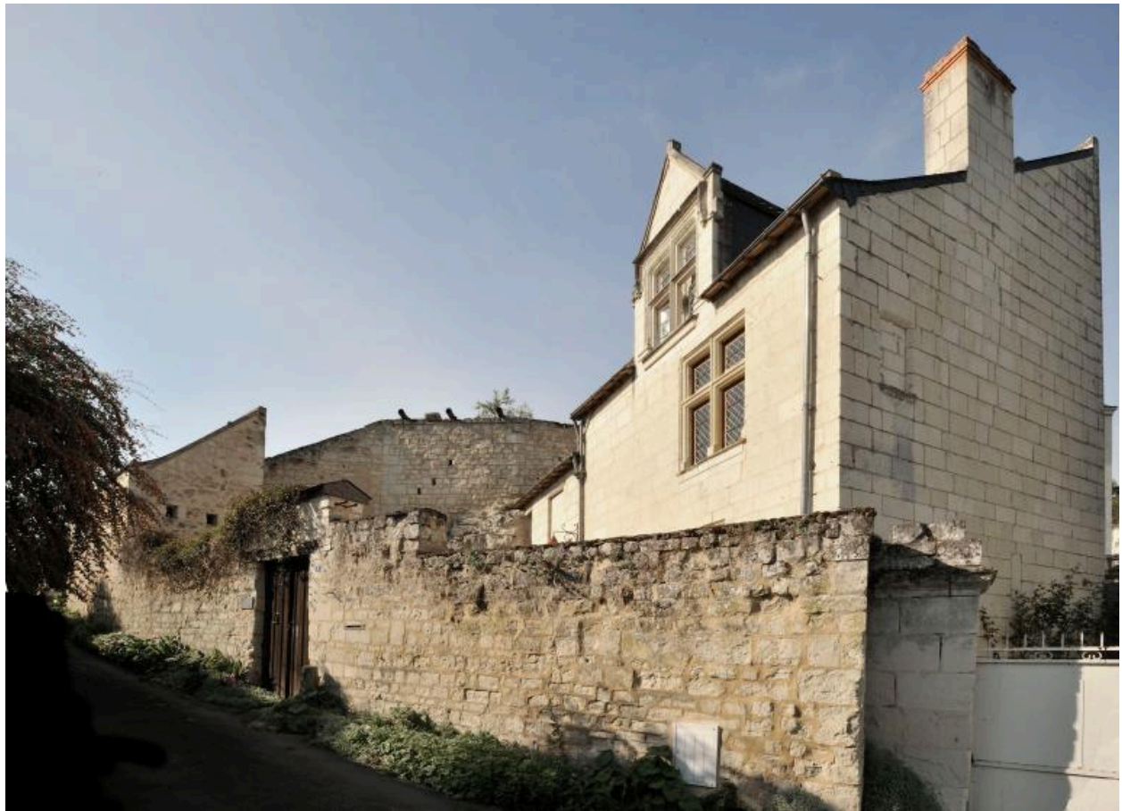
Vue sur l'ancien logis depuis la rue.
