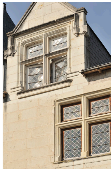
Corps nord : baie de l'étage (remplage restitué) et lucarne (probable remploi).
