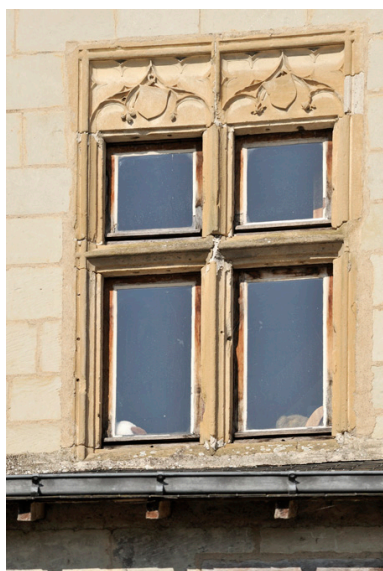
Croisée du corps sud (remploi), avec décor flamboyant et héraldique. Phot. Bruno Rousseau, Phot. Youenn Communeau IVR52_20114902556NUCA
