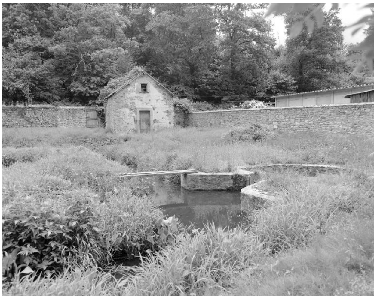
Partie est des bassins à poissons vue du nord. Au fond, contre le mur de clôture sud, le fournil de la maison éclusière.
