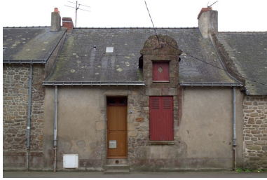
Façade sur rue. Phot. Denis Pillet IVR52_20074400121NUCA
