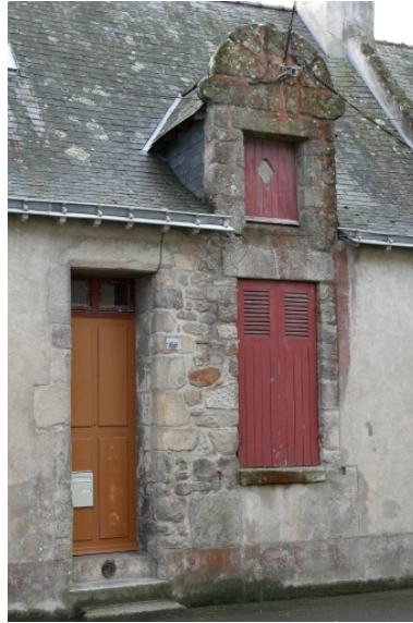
Façade sur rue. Phot. Denis Pillet IVR52_20064403098NUCA
