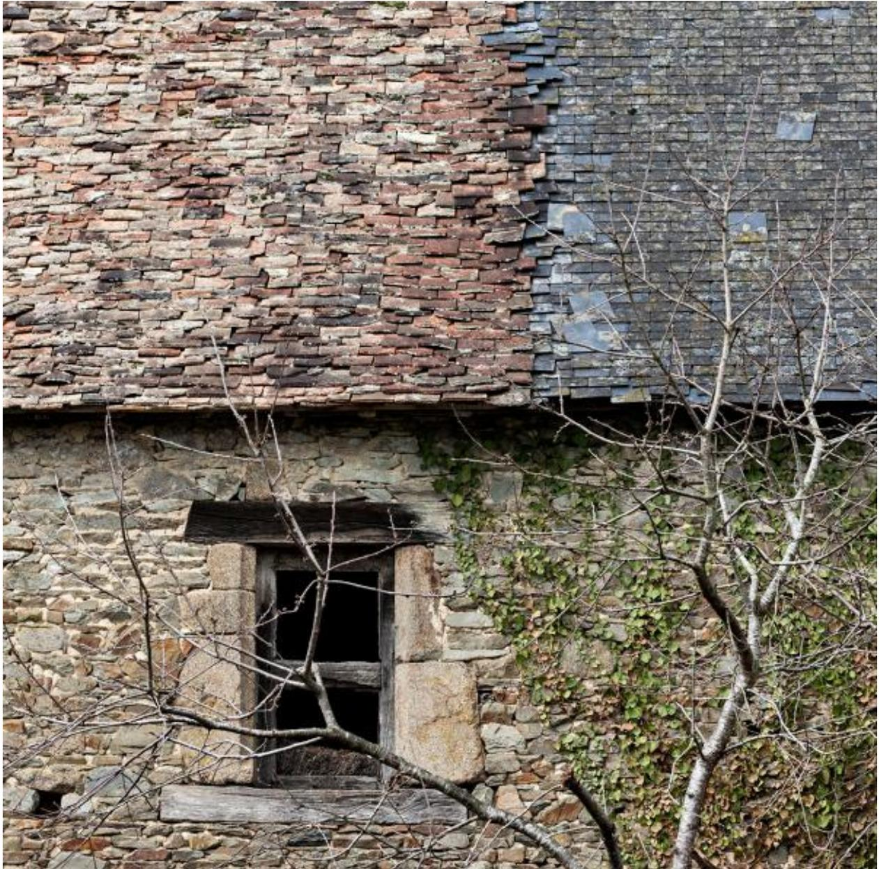
Toiture en tuile plate et en ardoise d'une des maisons de la Bouchardière (alignement est, pan oriental de la couverture)
