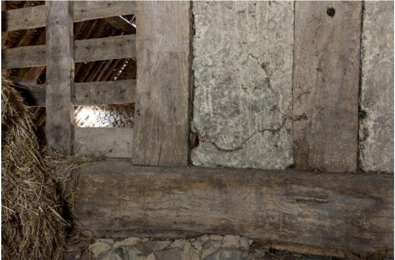
Détail du pan de bois de la ferme de charpente séparant les deux logis, alignement est, numéros d'assemblage
