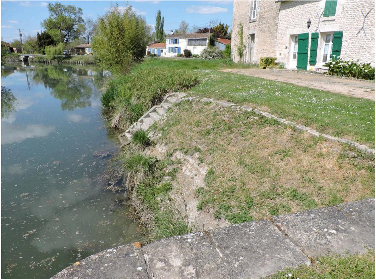
Vestiges de perré maçonné en aval de l'écluse, rive droite.
