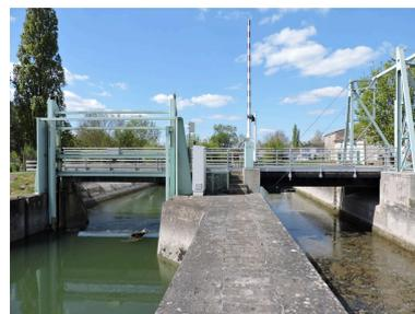
Vue depuis l'amont : à gauche le bassin du barrage, à droite le sas de l'écluse, franchi par le pont-levis.
