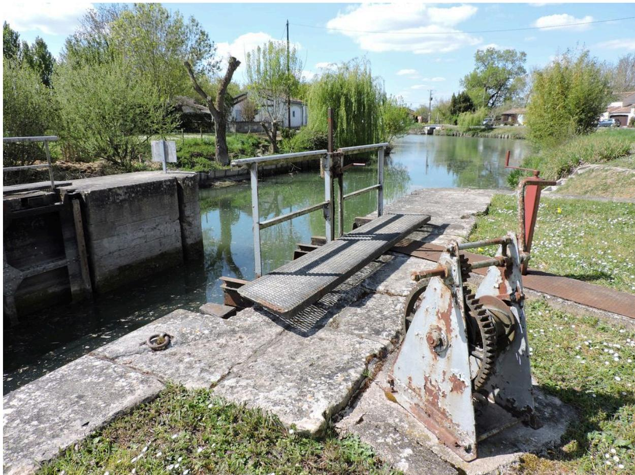
Mécanisme des portes de l'écluse du Mignon.
