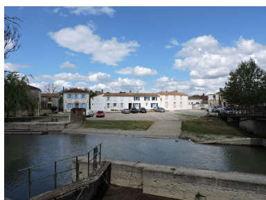
Le port vu depuis le sud. Phot. Yannis Suire IVR52_20218501235NUCA
