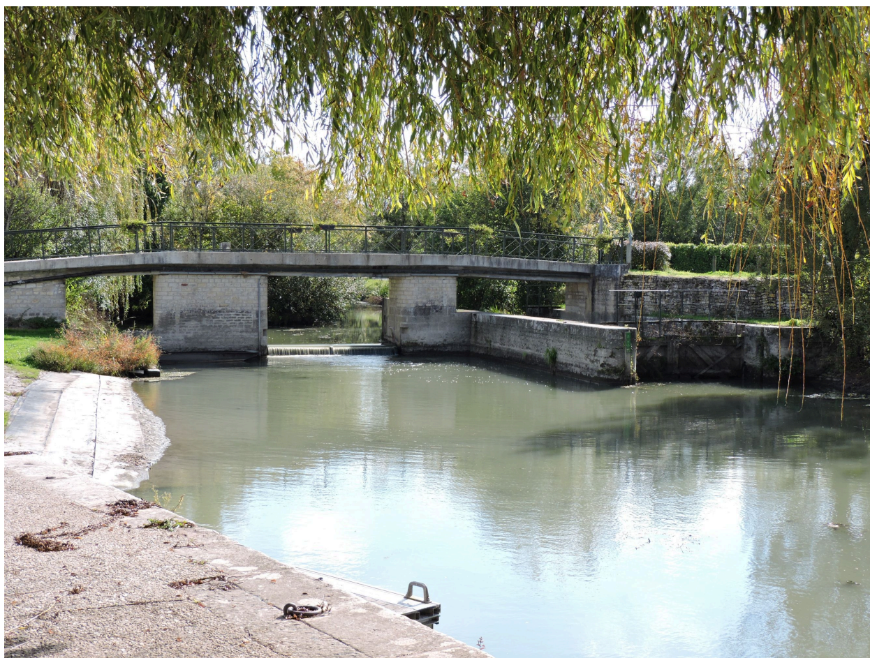
Le port et, à l'arrière-plan, le barrage éclusé du canal de Bourneau et le pont qui le franchit, vus depuis le nord-ouest.
