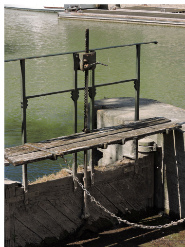
Détail de la porte aval de l'écluse, avec sa ventelle. Phot. Yannis Suire IVR52_20218501246NUCA
