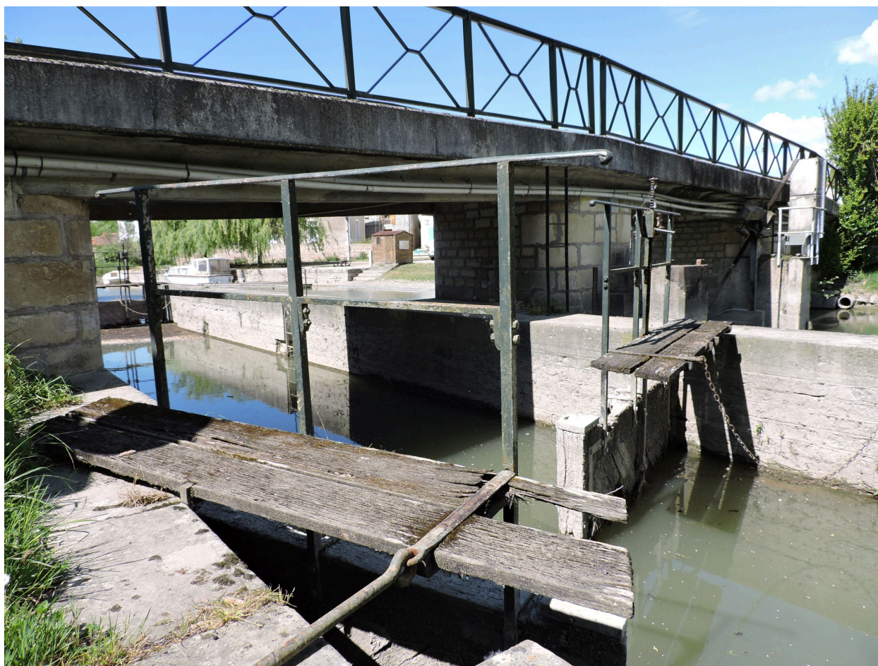
La porte amont de l'écluse.
