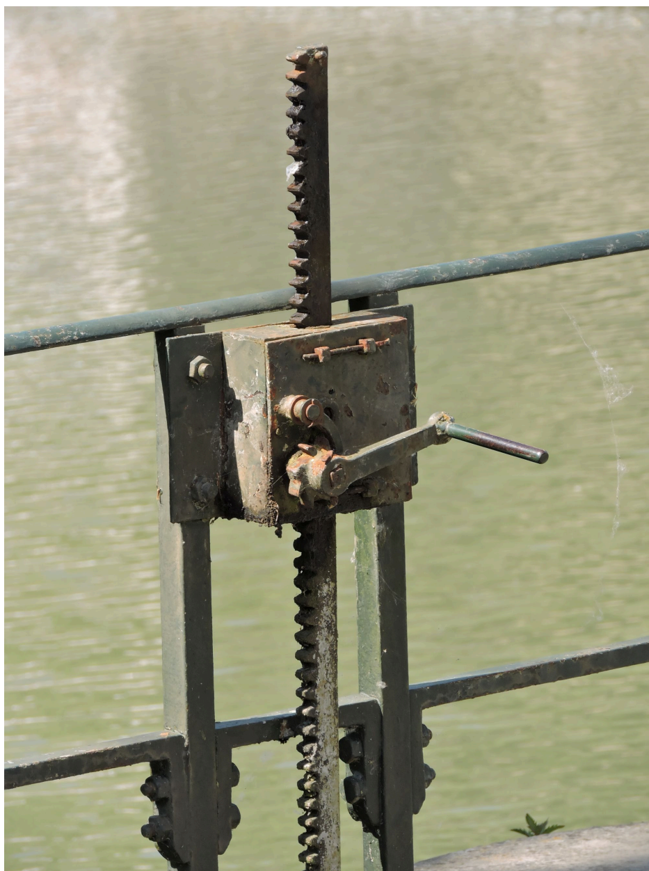
Détail de la porte aval de l'écluse : crémaillère à cric servant à manoeuvrer la ventelle.
