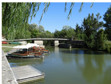
Le port et le pont vus depuis le nord-ouest. Phot. Yannis Suire IVR52_20218501134NUCA
