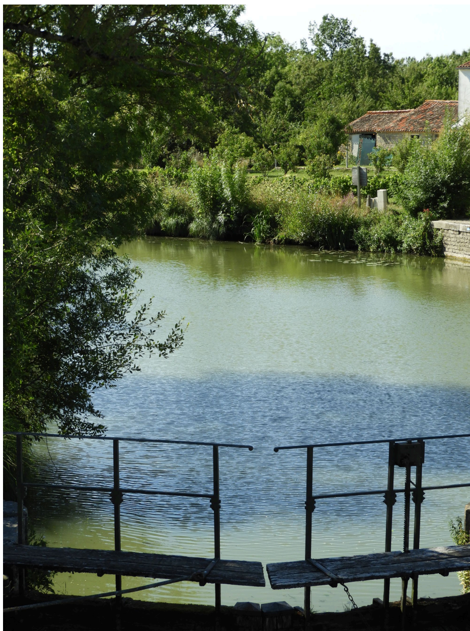
Le port et la porte aval de l'écluse.
