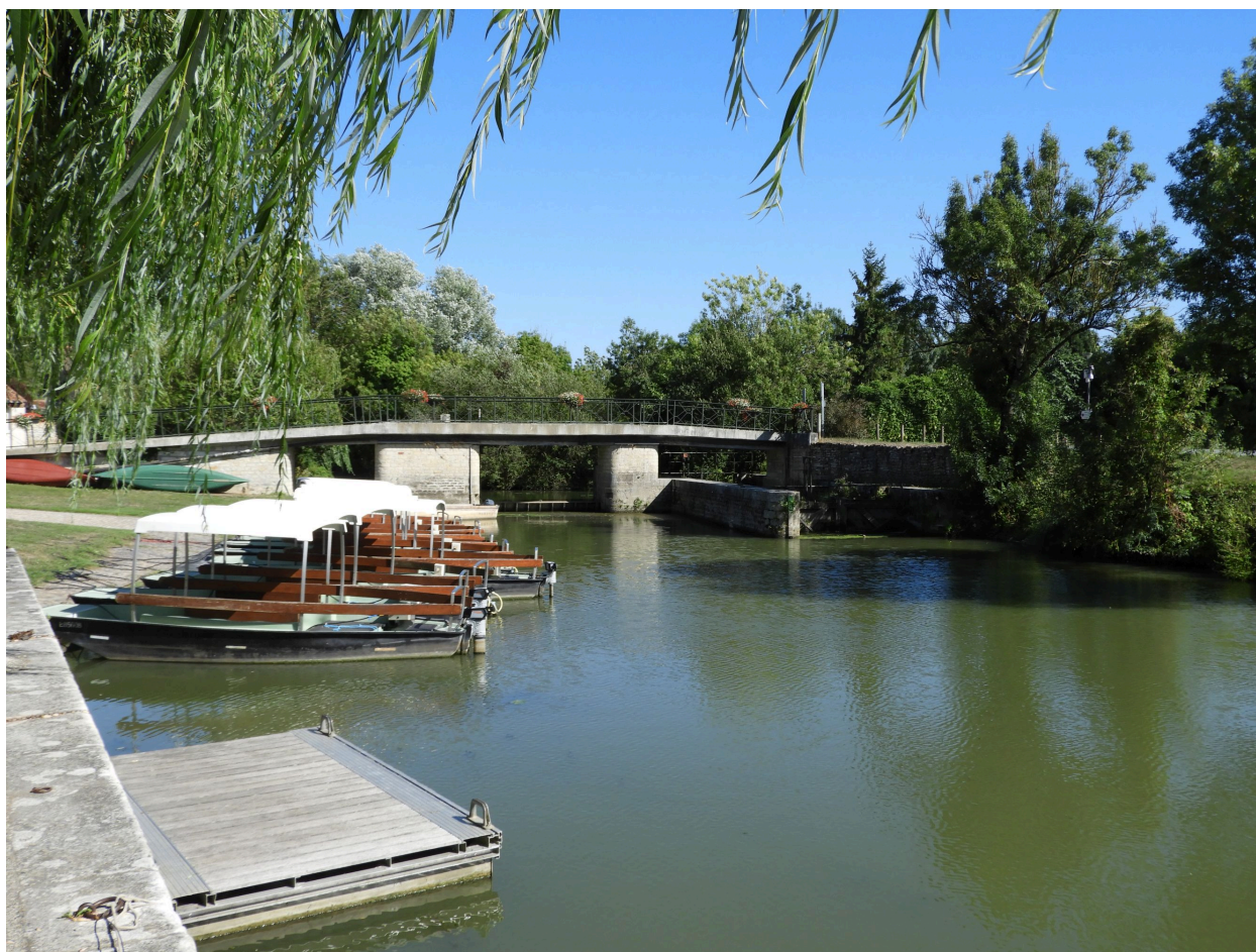
Le port et le pont vus depuis le nord-ouest.
