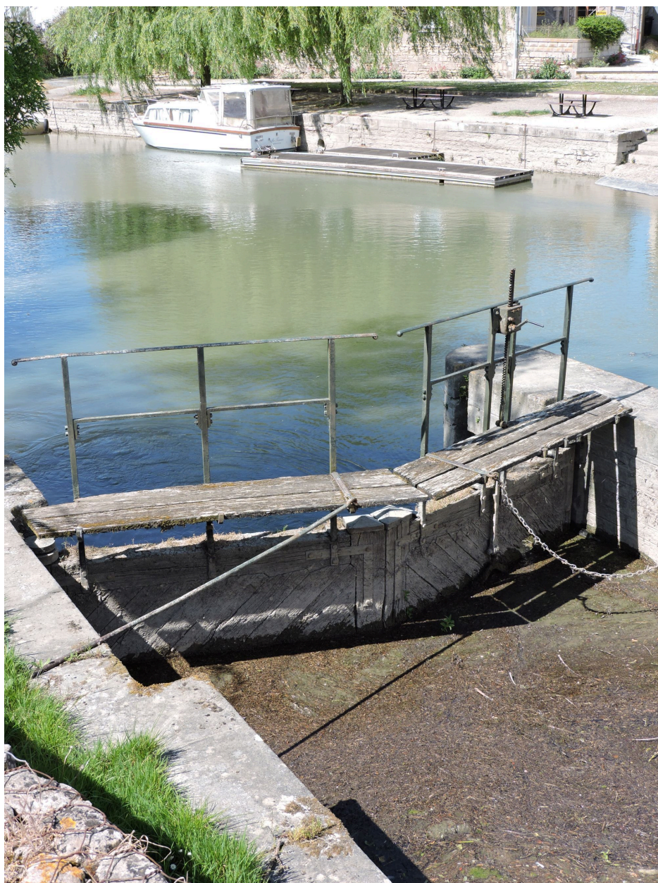
La porte aval de l'écluse.
