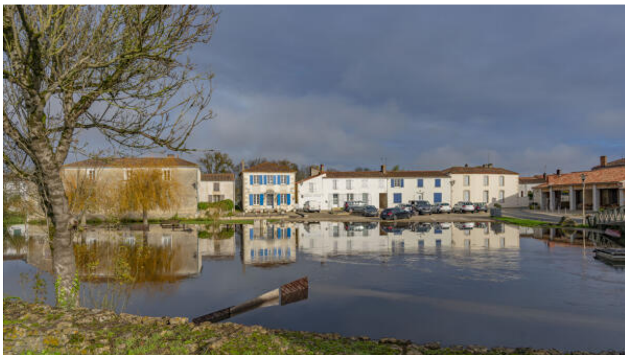
Le port de Maillé un jour d'inondation.
