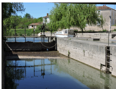
Le sas de l'écluse vu depuis l'amont. Phot. Yannis Suire IVR52_20218501253NUCA
