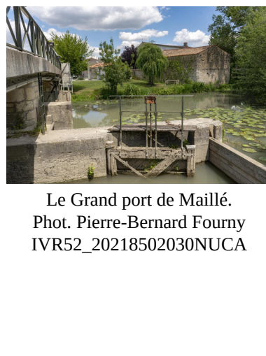
Détail de la porte aval de l'écluse, avec sa ventelle. Phot. Yannis Suire IVR52_20218501246NUCA
