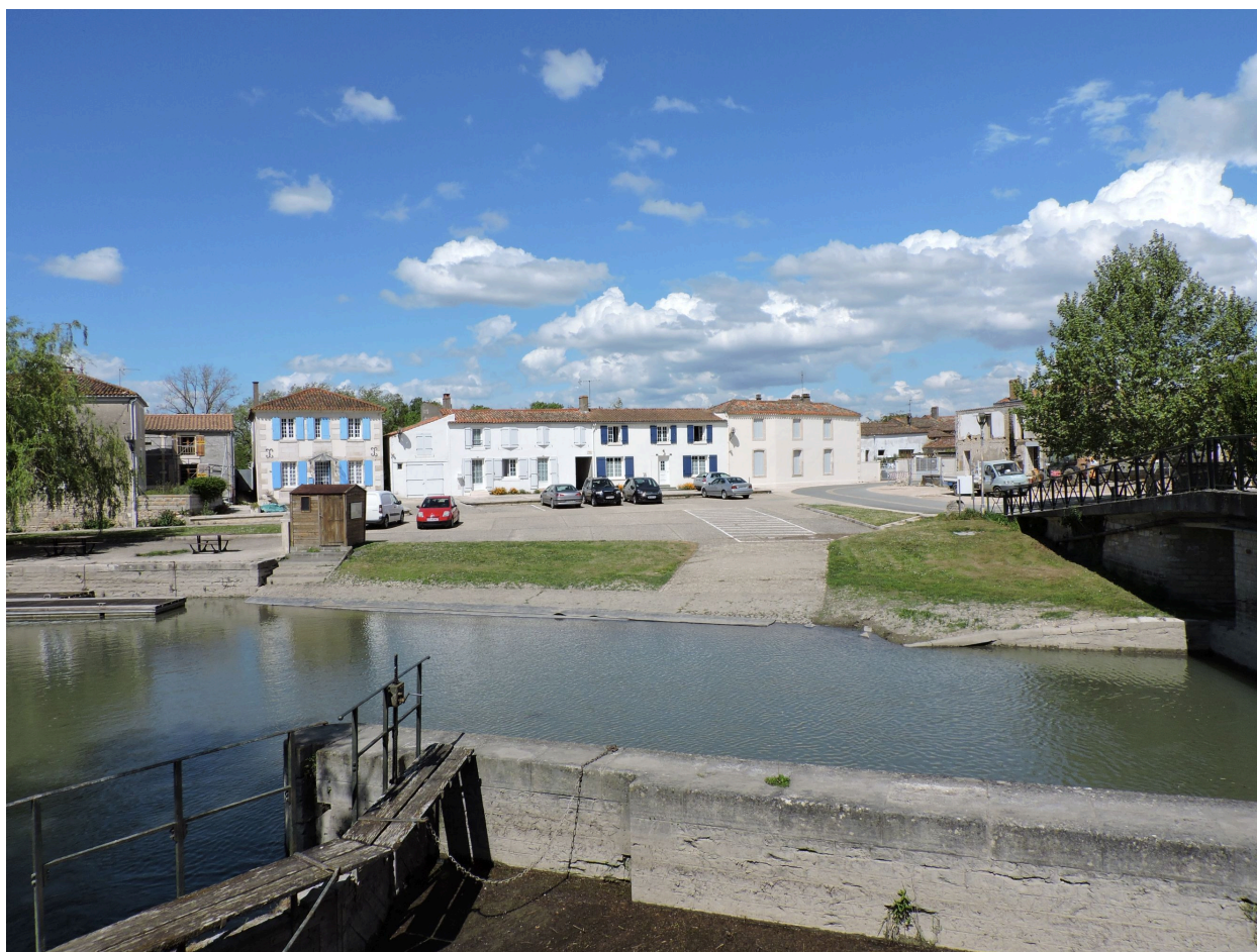
Le port vu depuis le sud.
