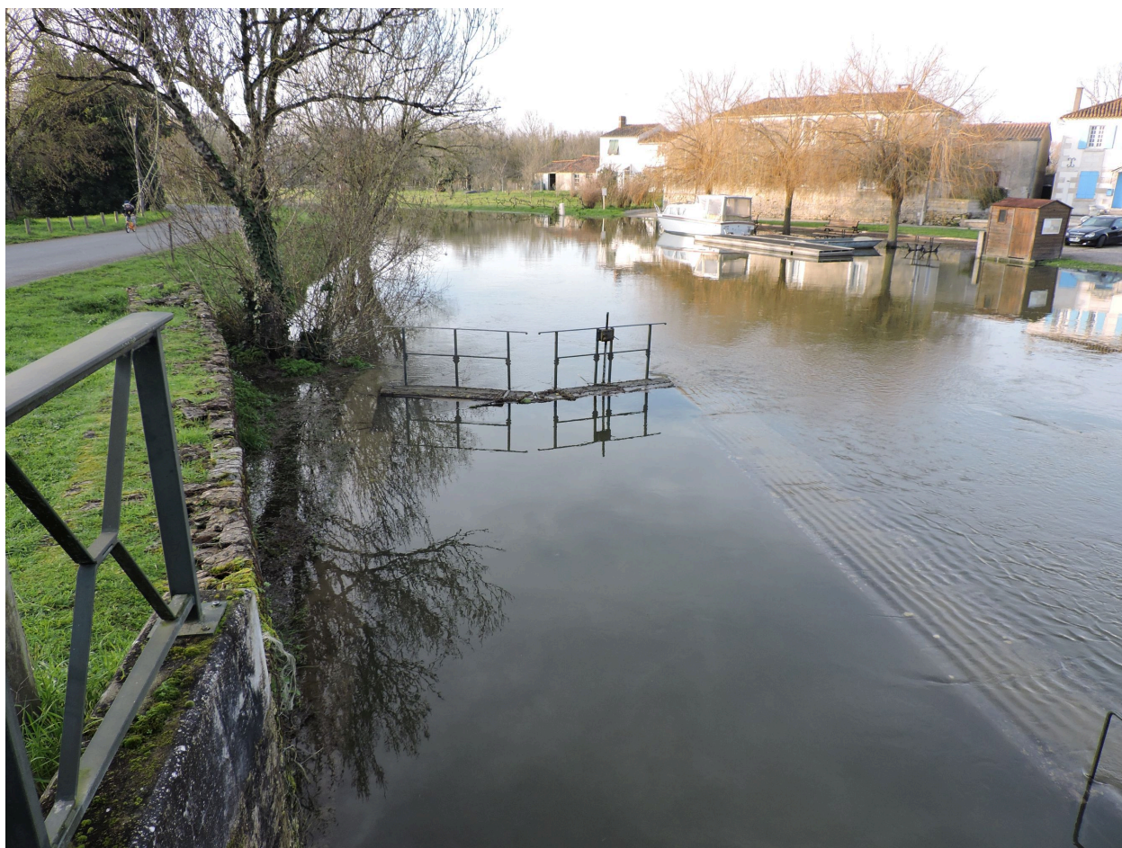
L'écluse submergée par l'inondation.
