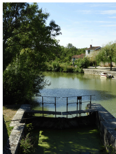
Le port et l'écluse. Phot. Yannis Suire IVR52_20218501131NUCA
