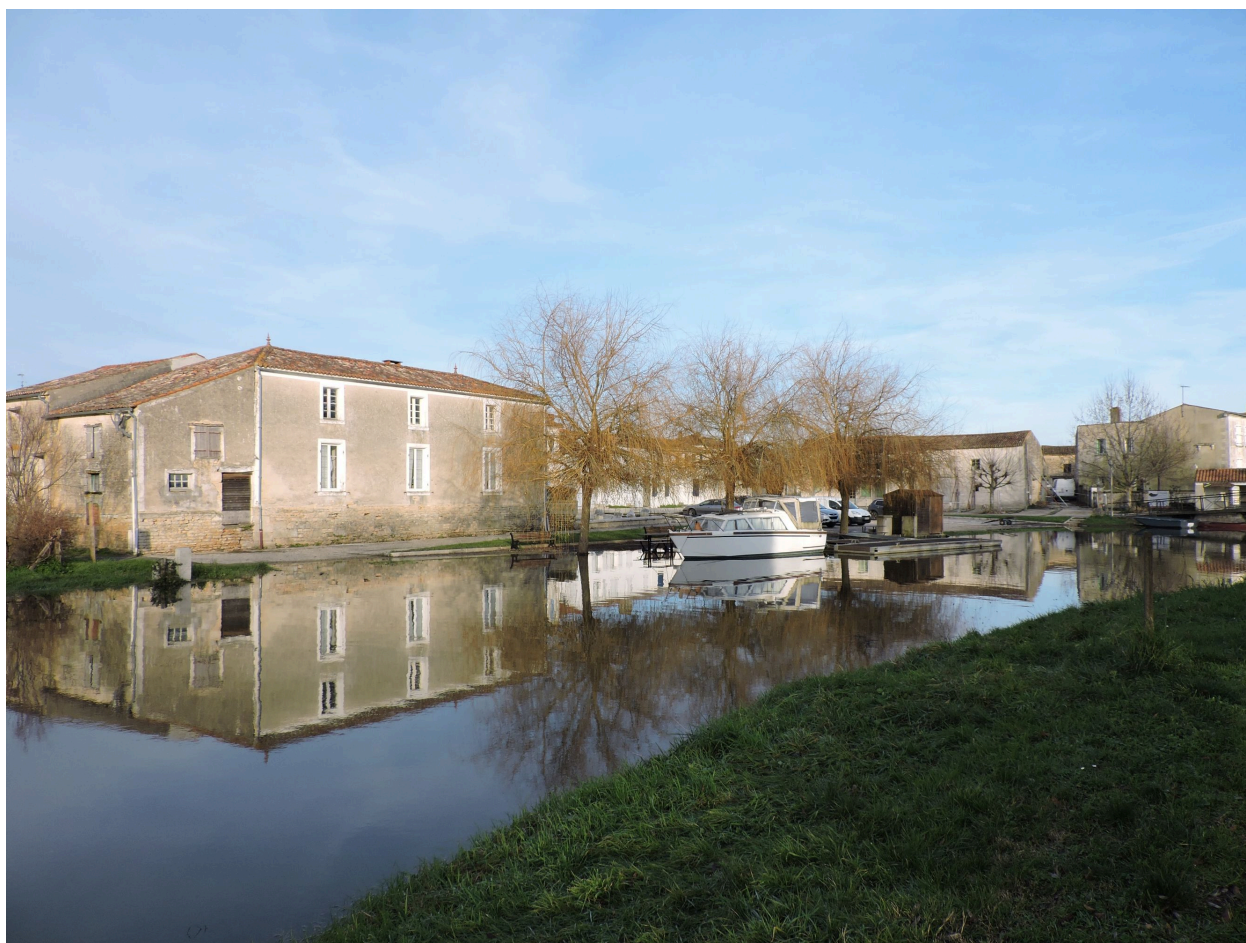
Le port vu depuis le sud-ouest, un jour d'inondation.
