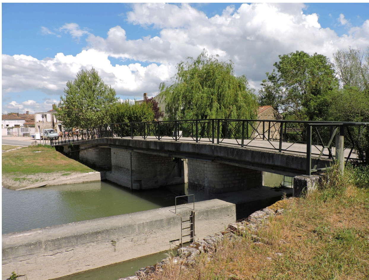
Le pont franchissant le barrage éclusé en amont du port, vu depuis le sud-ouest.
