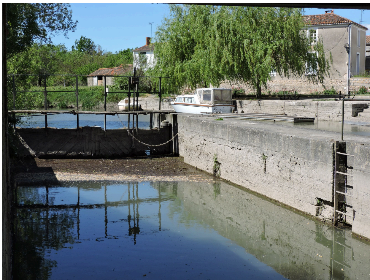
Le sas de l'écluse vu depuis l'amont.
