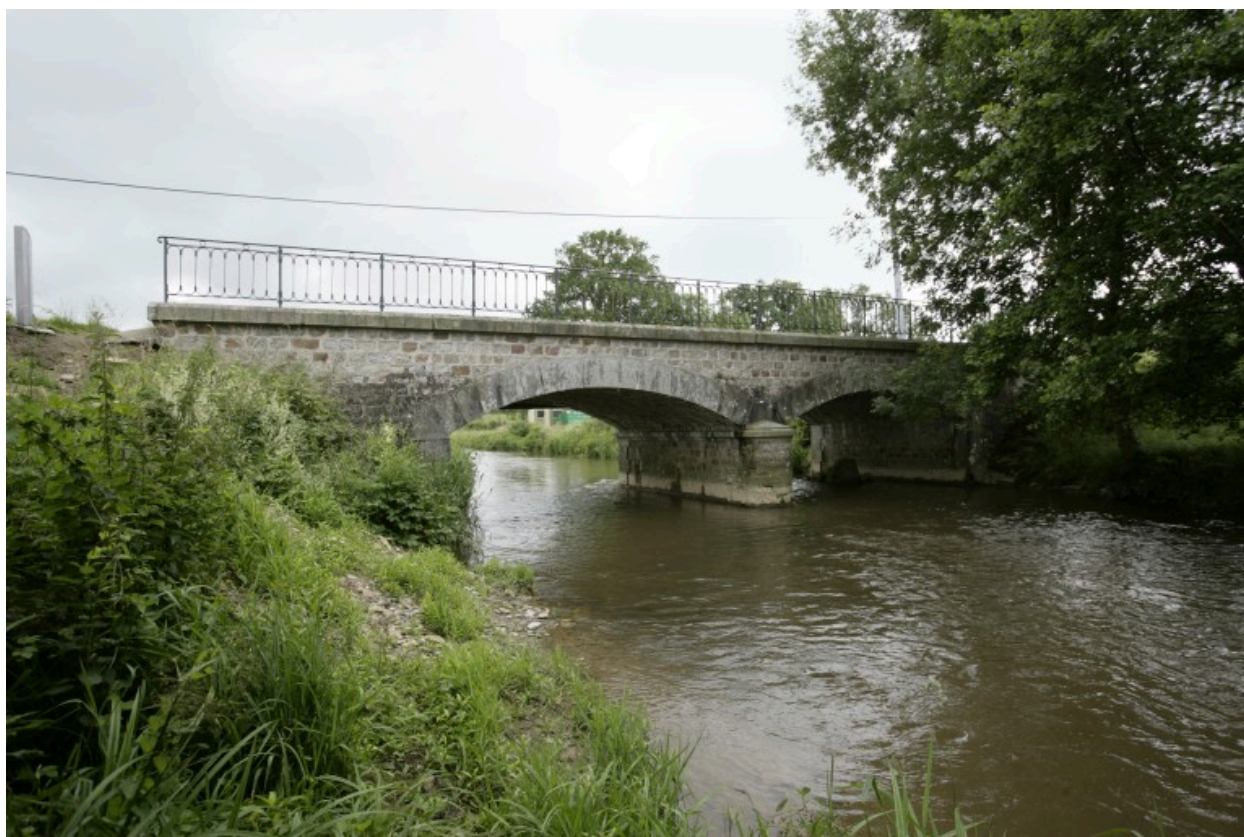
Vue d'aval depuis la rive droite.
