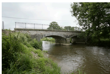
Vue d'aval depuis la rive droite. Phot. François Lasa IVR52_20075300380NUCA
