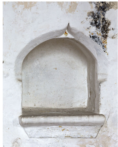
Nef, mur nord : lavabo mural surmonté d'une accolade dans la pierre. Phot. Pierre-Bernard Fourny IVR52_20137200241NUCA
