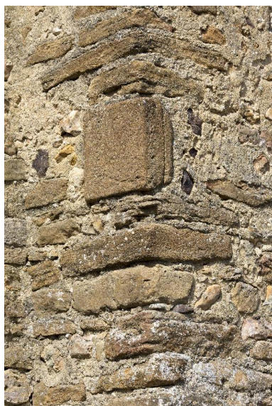
Nef, mur sud, contrefort central : détail du chaînage en grès roussard. Phot. Pierre-Bernard Fourny IVR52_20147200417NUCA
