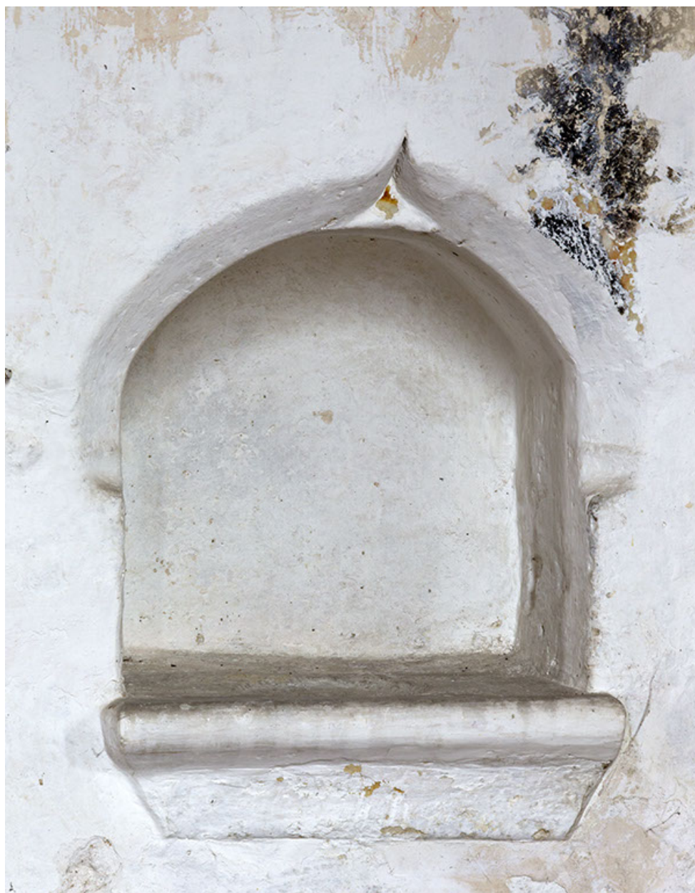
Nef, mur nord : lavabo mural surmonté d'une accolade dans la pierre.
