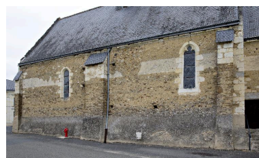
Nef : mur sud. Phot. Pierre-Bernard Fourny IVR52_20147200483NUCA
