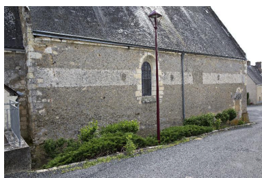
Nef : mur nord avec litre. Phot. Pierre-Bernard Fourny IVR52_20147200422NUCA
