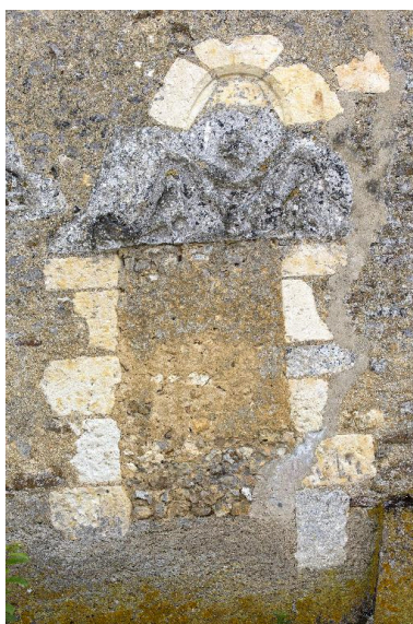
Nef, mur nord, détail : baie murée, éléments de décor mal repositionnés. Phot. Pierre-Bernard Fourny IVR52_20147200418NUCA
