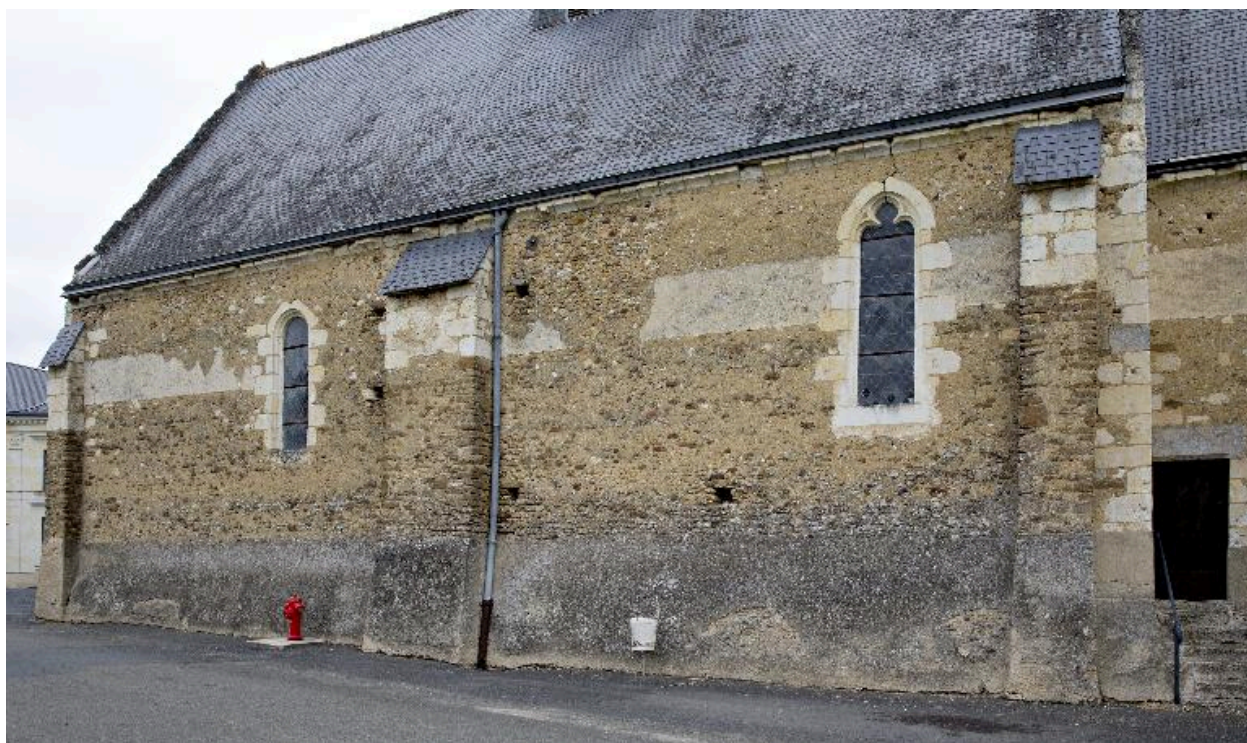
Nef : mur sud.
