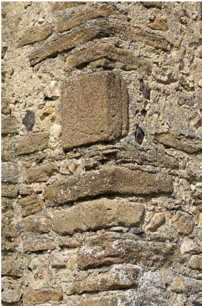
Nef, mur sud, contrefort central : détail du chaînage en grès roussard.
