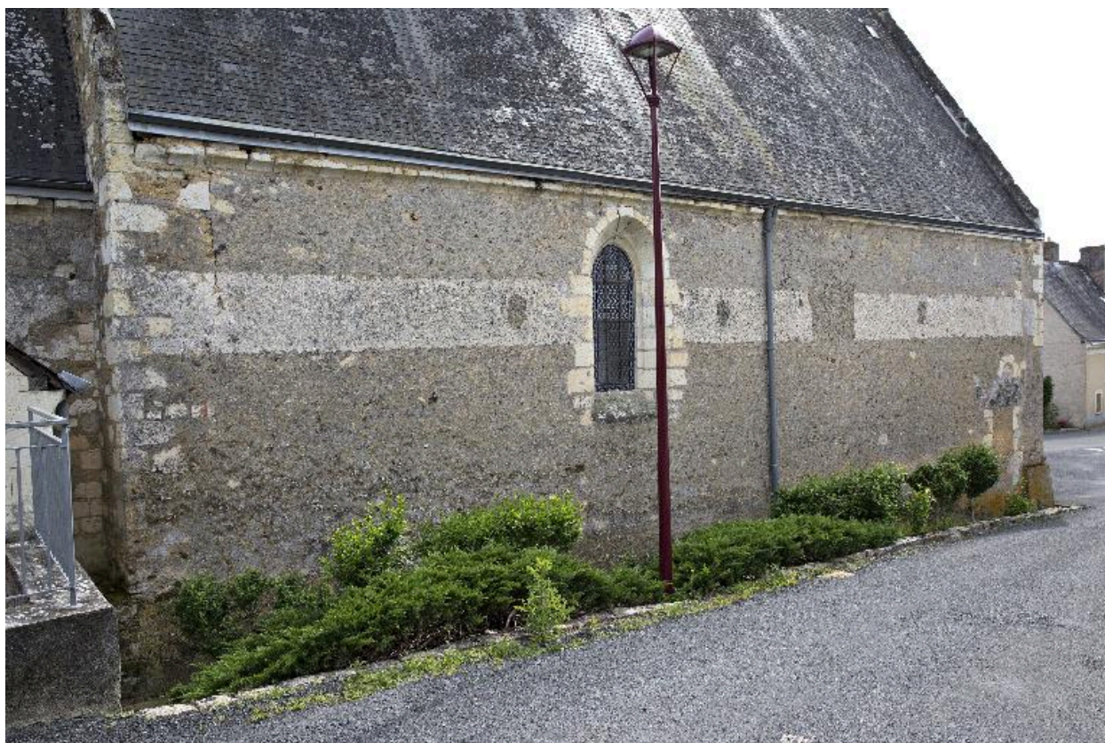
Nef : mur nord avec litre.
