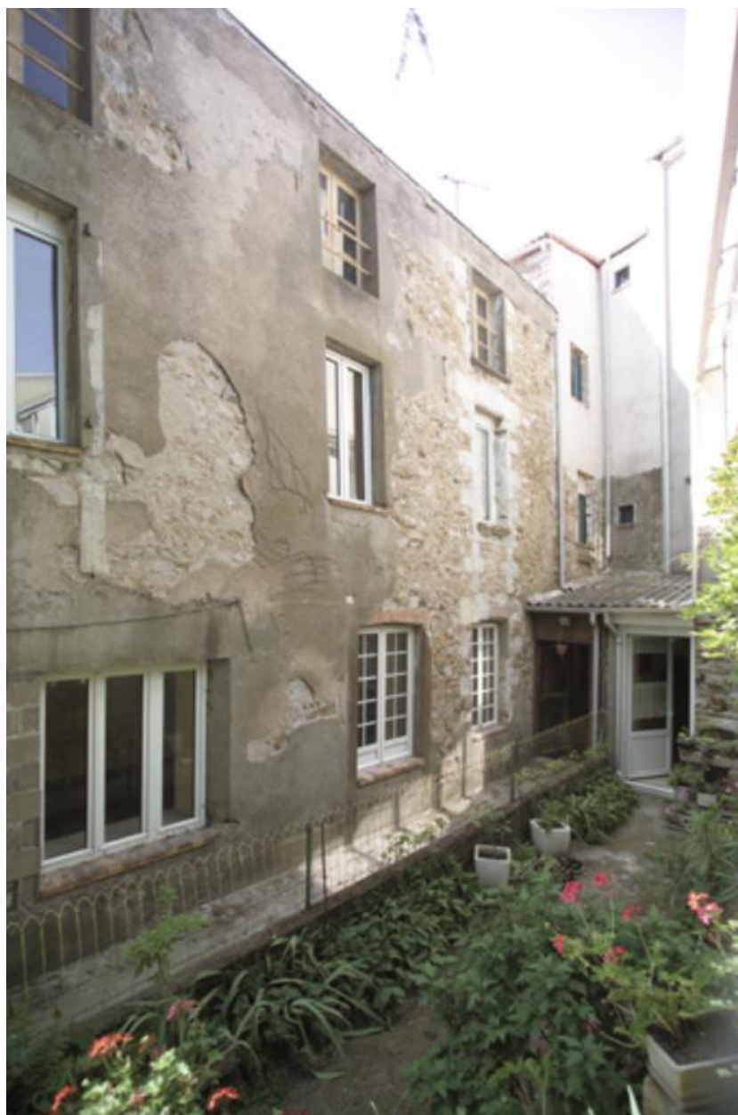
Vue du corps secondaire, du corps d'escalier et de la façade postérieure (une travée) prise depuis le jardin voisin.
