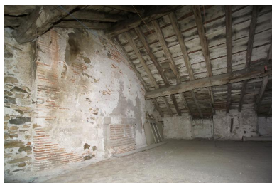
Vue de l'étage de comble, les lucarnes ayant été bouchées sur la rue, à gauche, une cheminée en tufeau. Phot. Denis Pillet IVR52_20034400500NUCA
