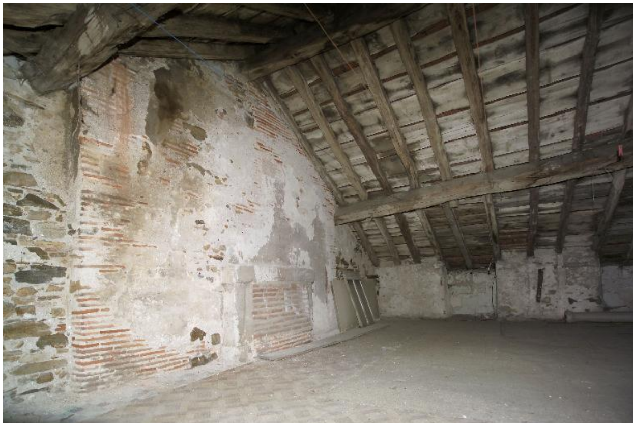
Vue de l'étage de comble, les lucarnes ayant été bouchées sur la rue, à gauche, une cheminée en tufeau.
