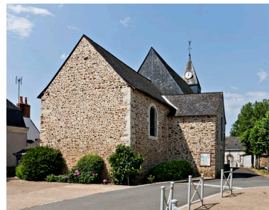
Vue d'ensemble depuis le nord-est. Phot. Yves Guillotin IVR52_20155300184NUCA
