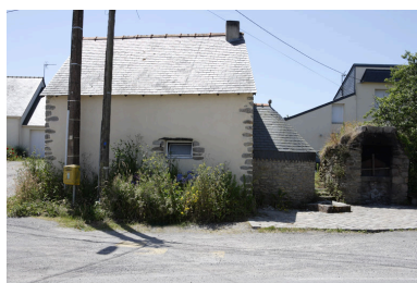
Vue du fournil. Phot. Denis Pillet IVR52_20084402132NUCA
