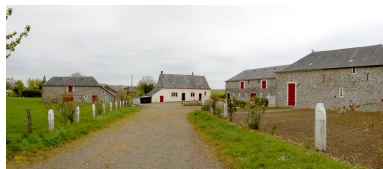
Vue d'ensemble depuis la route de Chéméré-le-Roi au sud-est : de gauche à droite, la petite étable, le logis, l'étable-grange, la remise. Phot. François Lasa IVR52_20045301439NUCA
