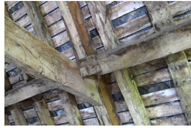
Détail d'une ferme de la charpente du logis : assemblage du faux entrain avec la panne intermédiaire et le chevron. Phot. François Lasa IVR52_20045301444NUCA
