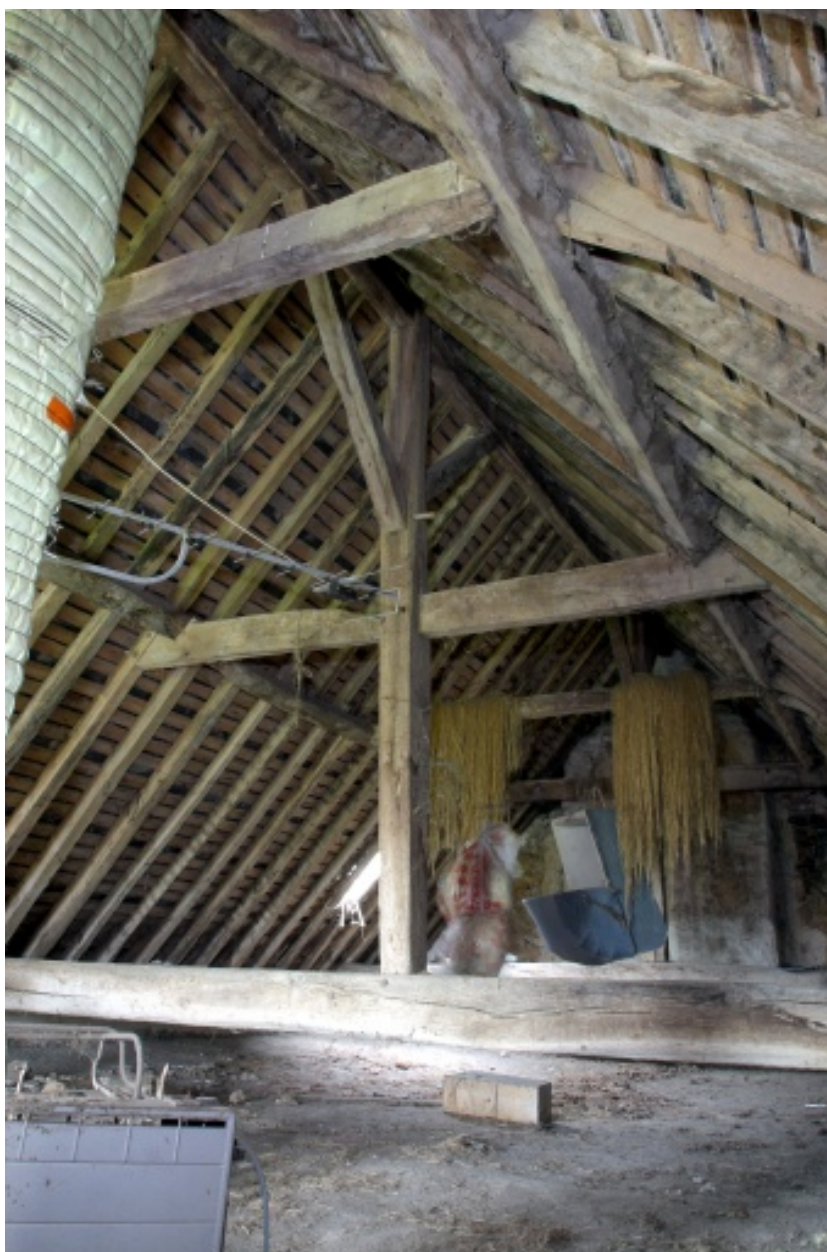
La charpente du logis vue depuis l'est.
