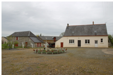
La petite étable et le logis. Phot. François Lasa IVR52_20045301440NUCA
