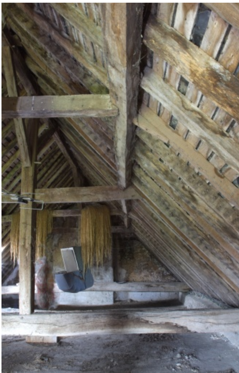
Demi-ferme de la charpente du logis vue depuis l'est.
