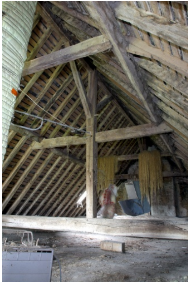
La charpente du logis vue depuis l'est. Phot. François Lasa IVR52_20045301442NUCA
