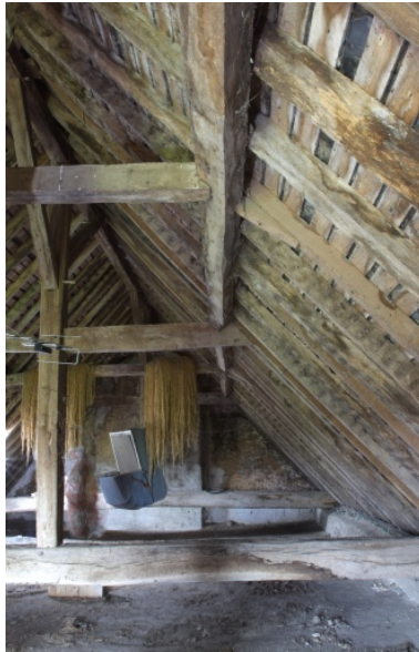
Demi-ferme de la charpente du logis vue depuis l'est. Phot. François Lasa IVR52_20045301443NUCA
