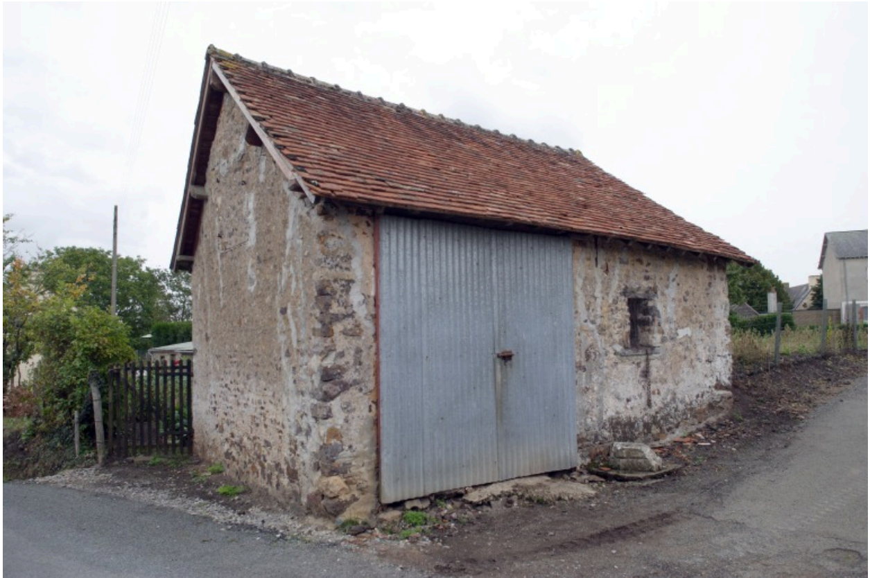
Vue depuis le croisement formé par la rue de la Croix-Hubert et la voie de la vitre.
