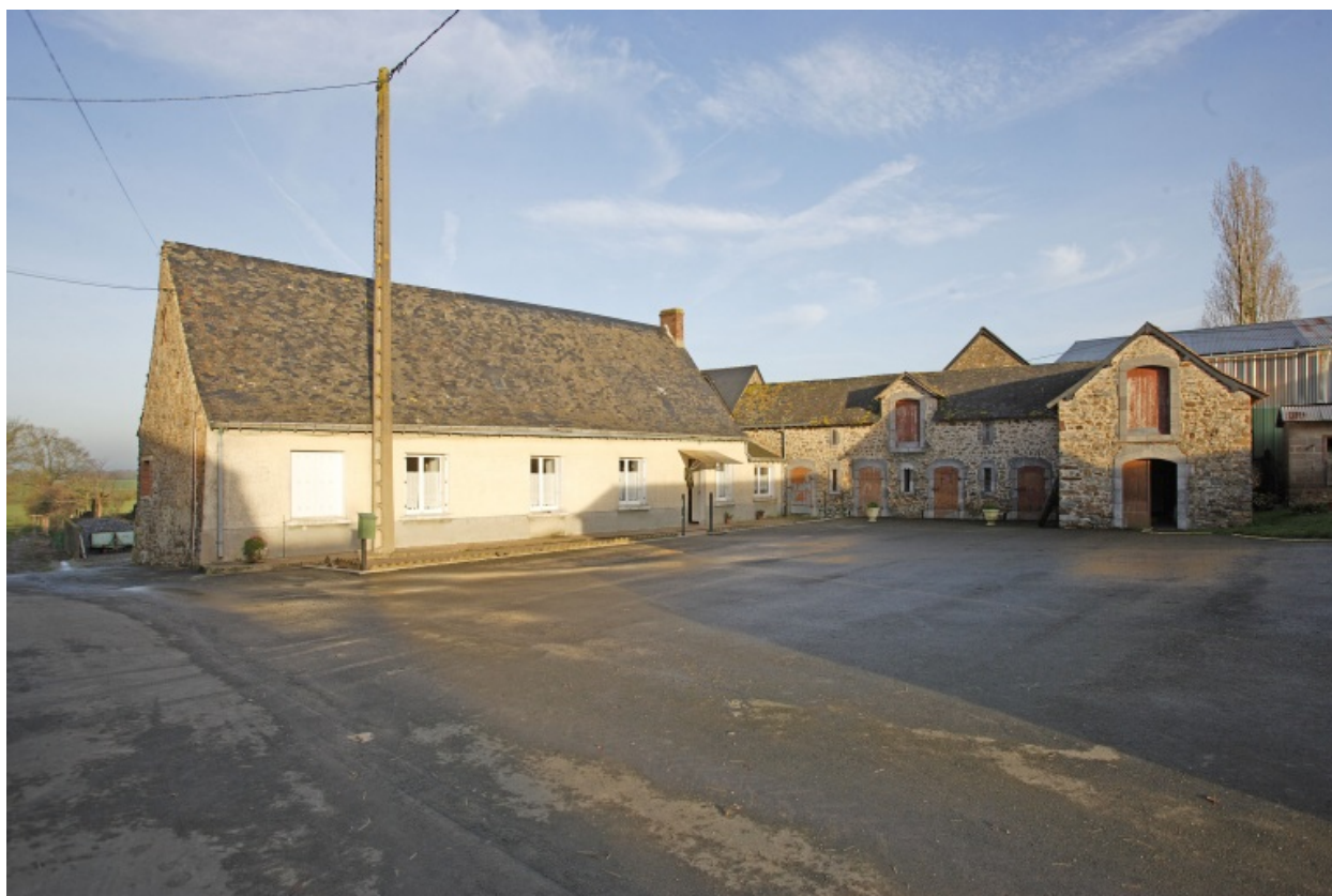
Ferme ouest : le logis et la porcherie vus depuis le sud-ouest.
