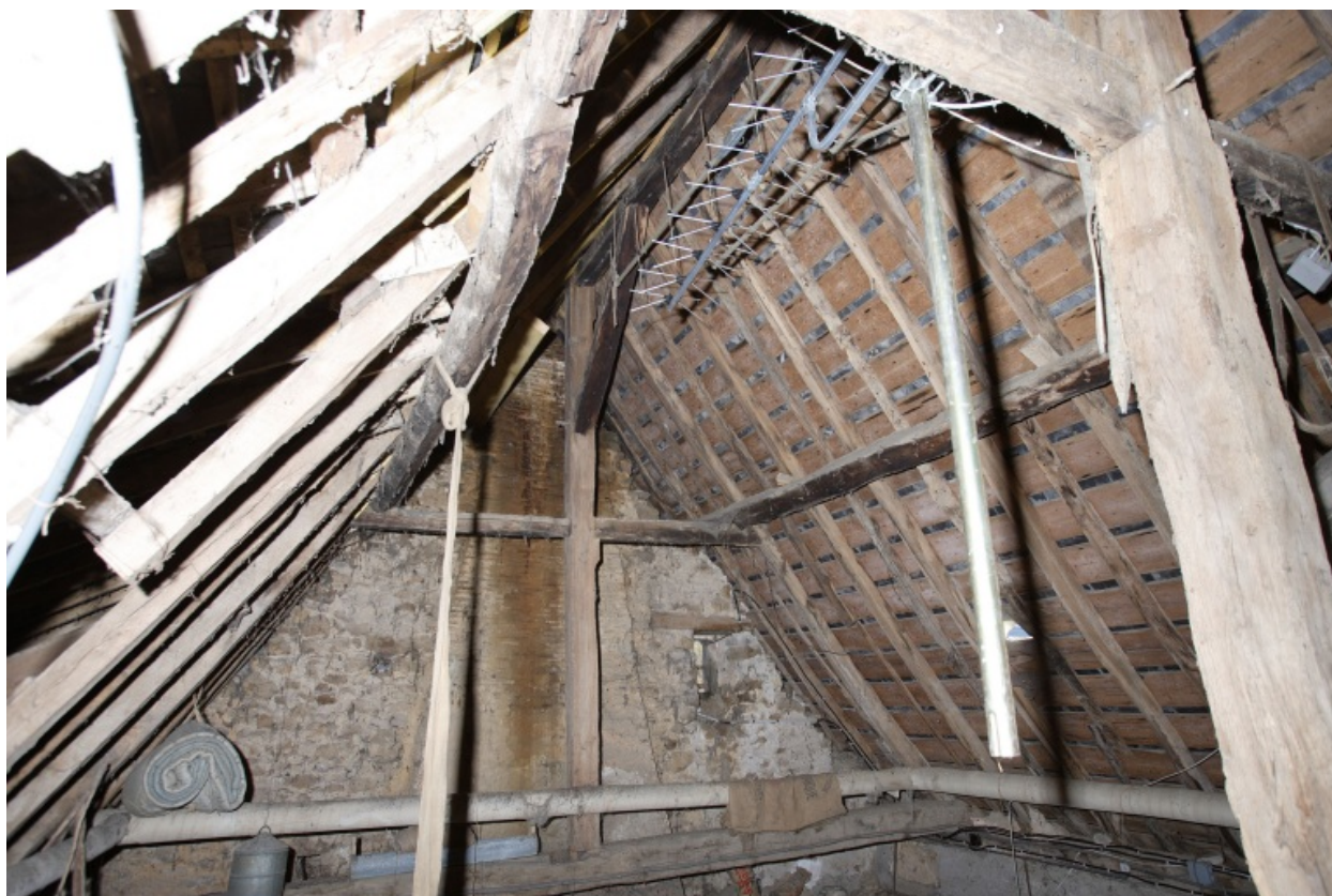
Ferme ouest : la partie est de la charpente du logis.
