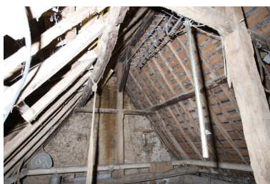
Ferme ouest : la partie est de la charpente du logis. Phot. François Lasa IVR52_20065302845NUCA
