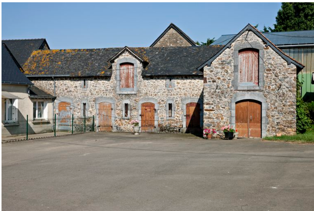
Ferme ouest : la porcherie vue depuis l'ouest.
