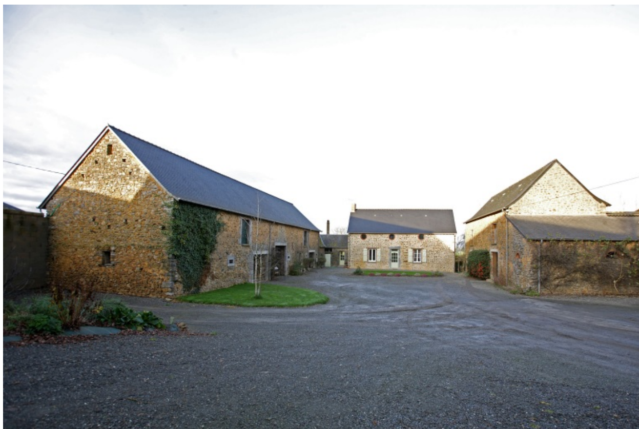
Ferme est : vue d'ensemble depuis le sud.
