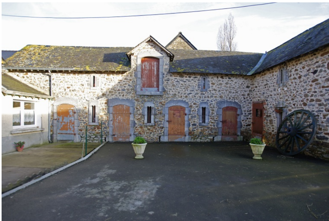
Ferme ouest : la porcherie vue depuis l'ouest.
