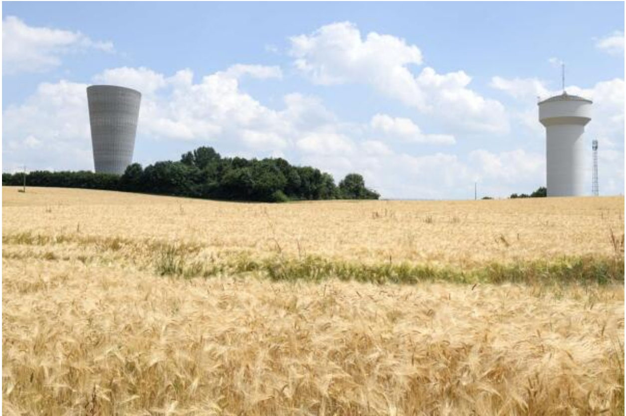
Beausse. Vue des châteaux d'eau de la Fribaudière depuis le nord-ouest.
