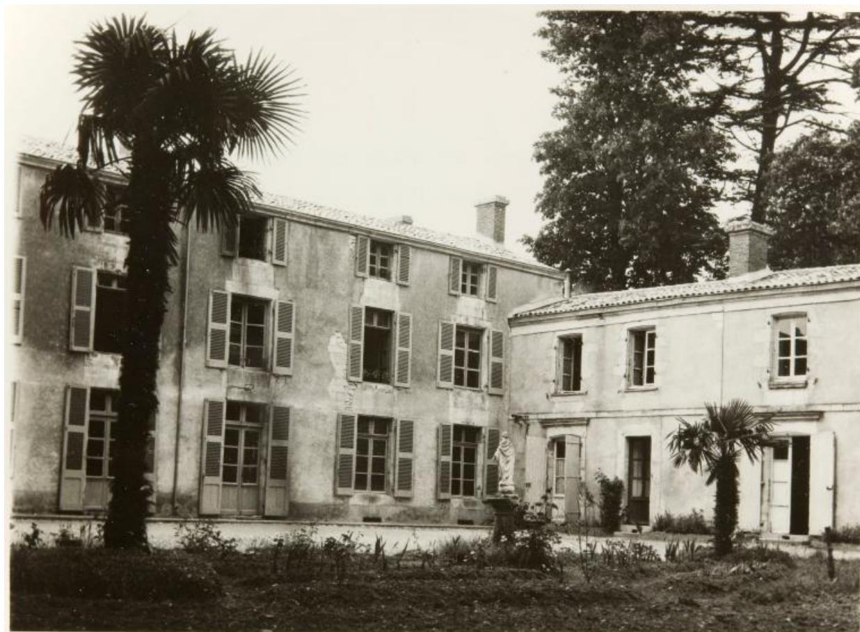
Vue des bâtiments sur cour. Photo prise au milieu du XXe siècle par les Missionnaires de la Plaine.
