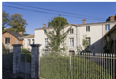
Vue de la façade sur rue. A droite, la chapelle construite par les Missionnaires de la Plaine en 1956. Phot. Patrice Giraud IVR52_20098500529NUCA
