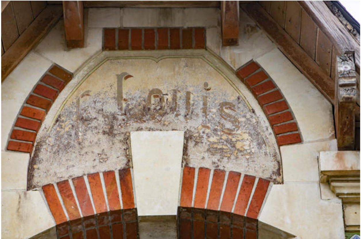
Maison, 1 rue de la Plage. Détail de l'inscription sur la façade antérieure.
