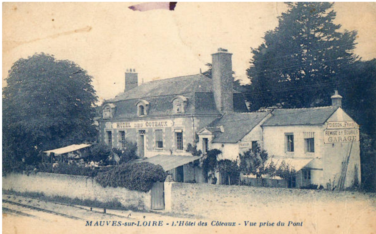
L'Hôtel des Coteaux à Mauves-sur-Loire. Vue prise du pont. Carte postale, début du 20e siècle.
