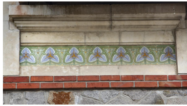
Maison, 1 rue de la Plage. Détail de la frise en carreaux de céramique de la façade antérieure. Phot. Pierre-Bernard Fourny IVR52_20214400888NUCA
