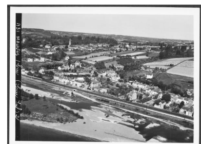
Vue aérienne du quartier du Port. IVR52_20204400756NUCA
