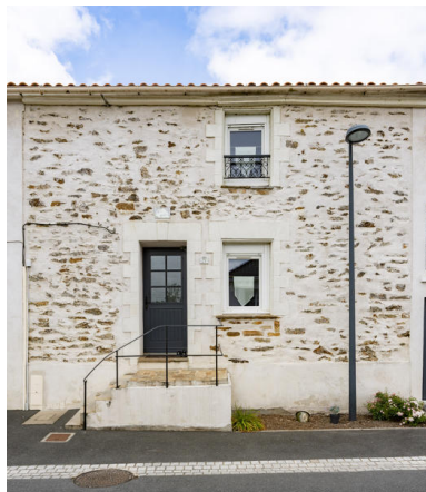
Maison, 21 rue de la Loire. Phot. Pierre-Bernard Fourny IVR52_20214400882NUCA
