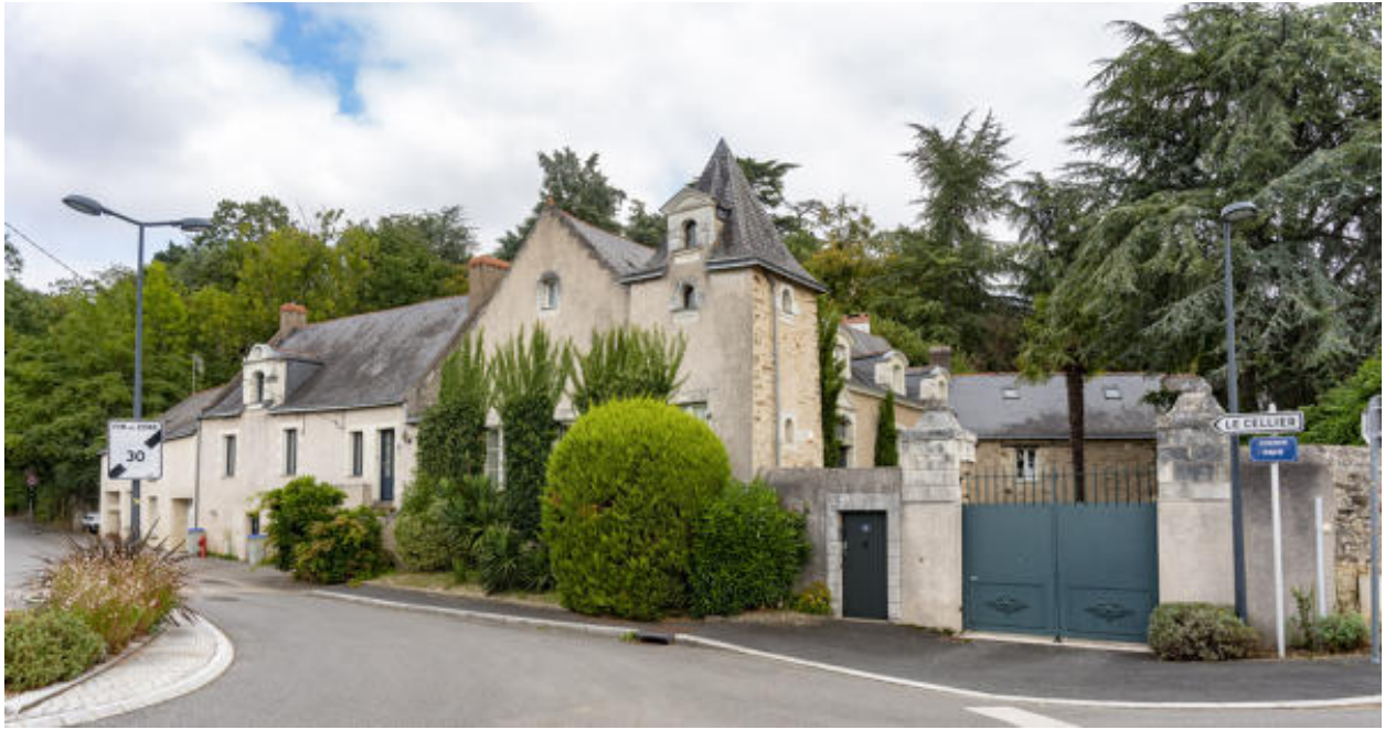
Ensemble de deux maisons, 2 et 4 chemin Pavé.
