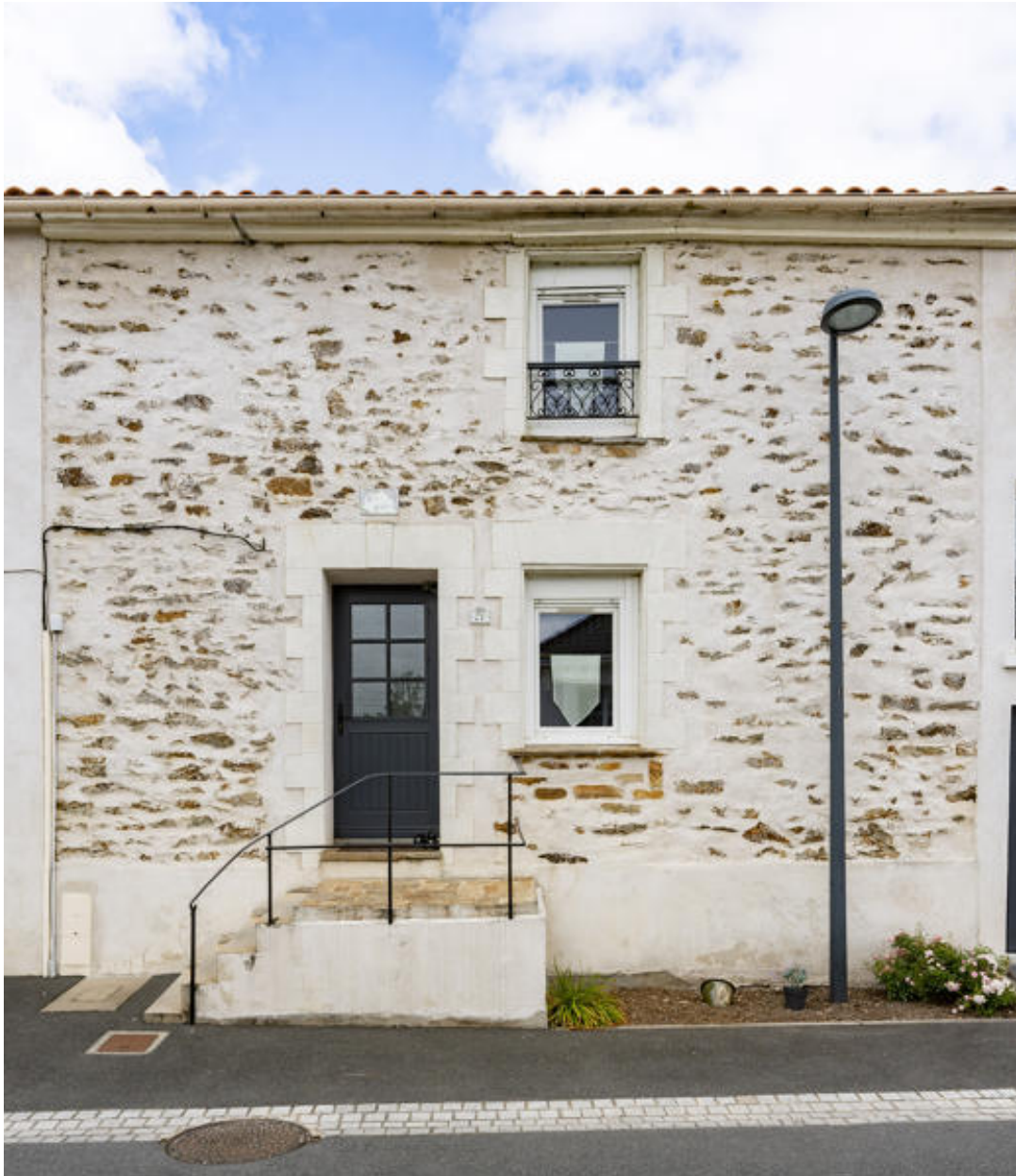
Maison, 21 rue de la Loire.
