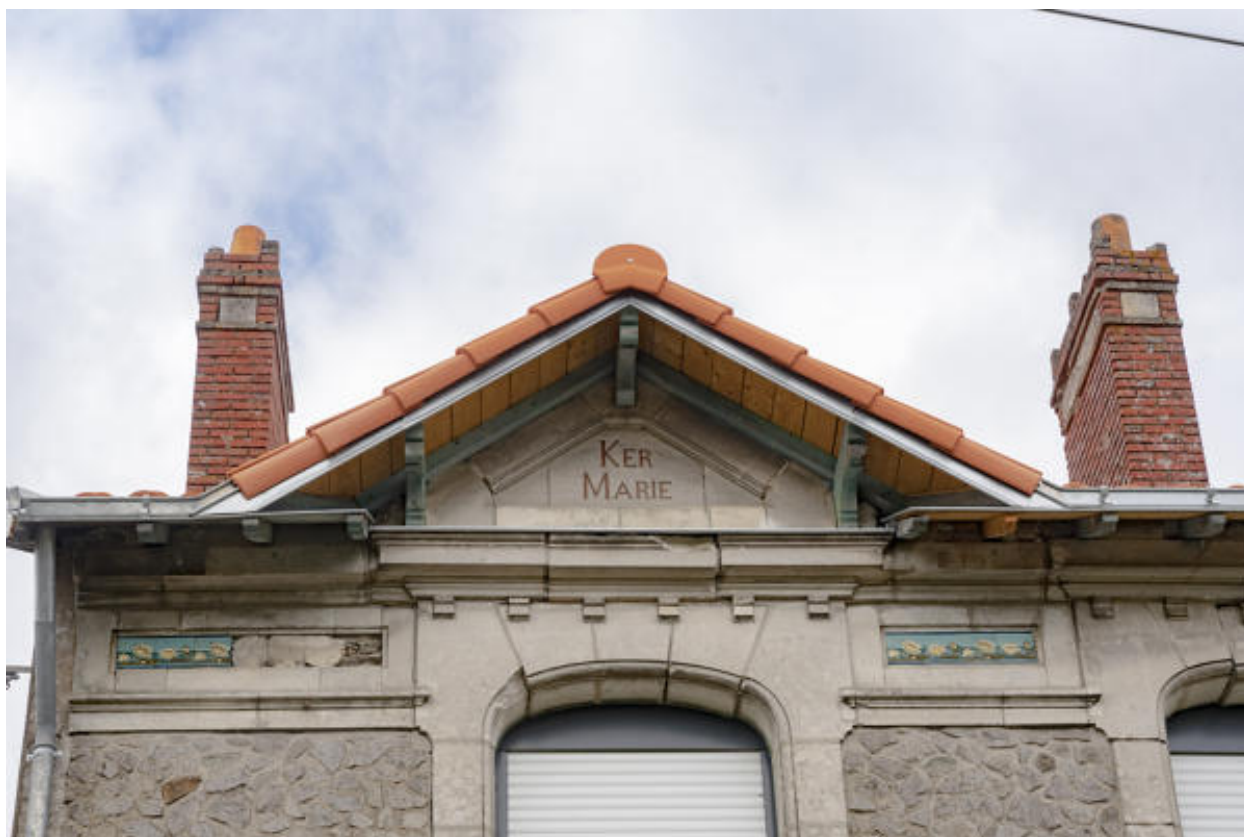
Maison "Ker Marie", 7 rue Port. Détail du traitement décoratif de la façade antérieure.
