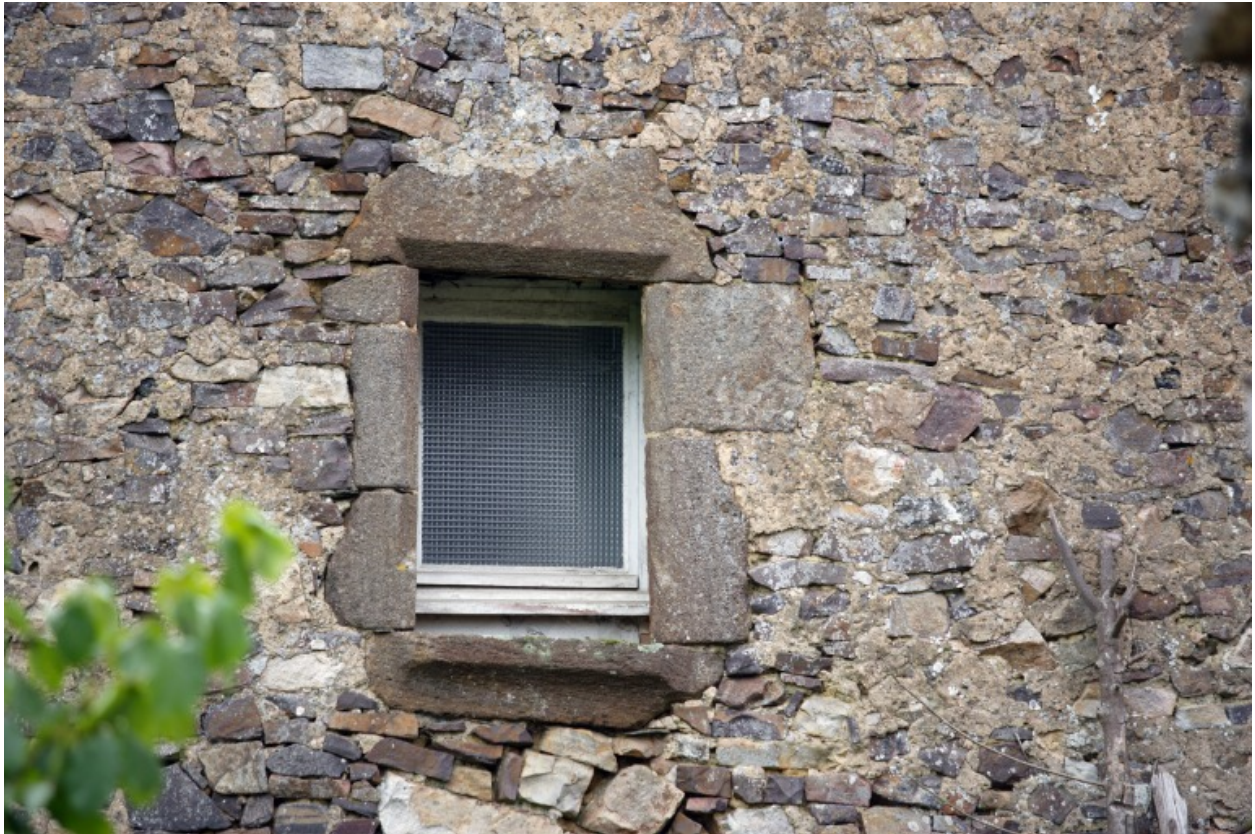
Détail de la façade postérieure : fenêtre.
