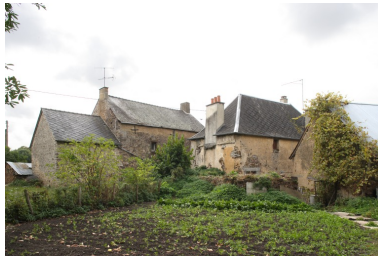
La façade postérieure, vue depuis le jardin de l'ancienne ferme de la Butte à l'ouest. A droite, la maison de la Butte. Phot. François Lasa IVR52_20055302073NUCA
