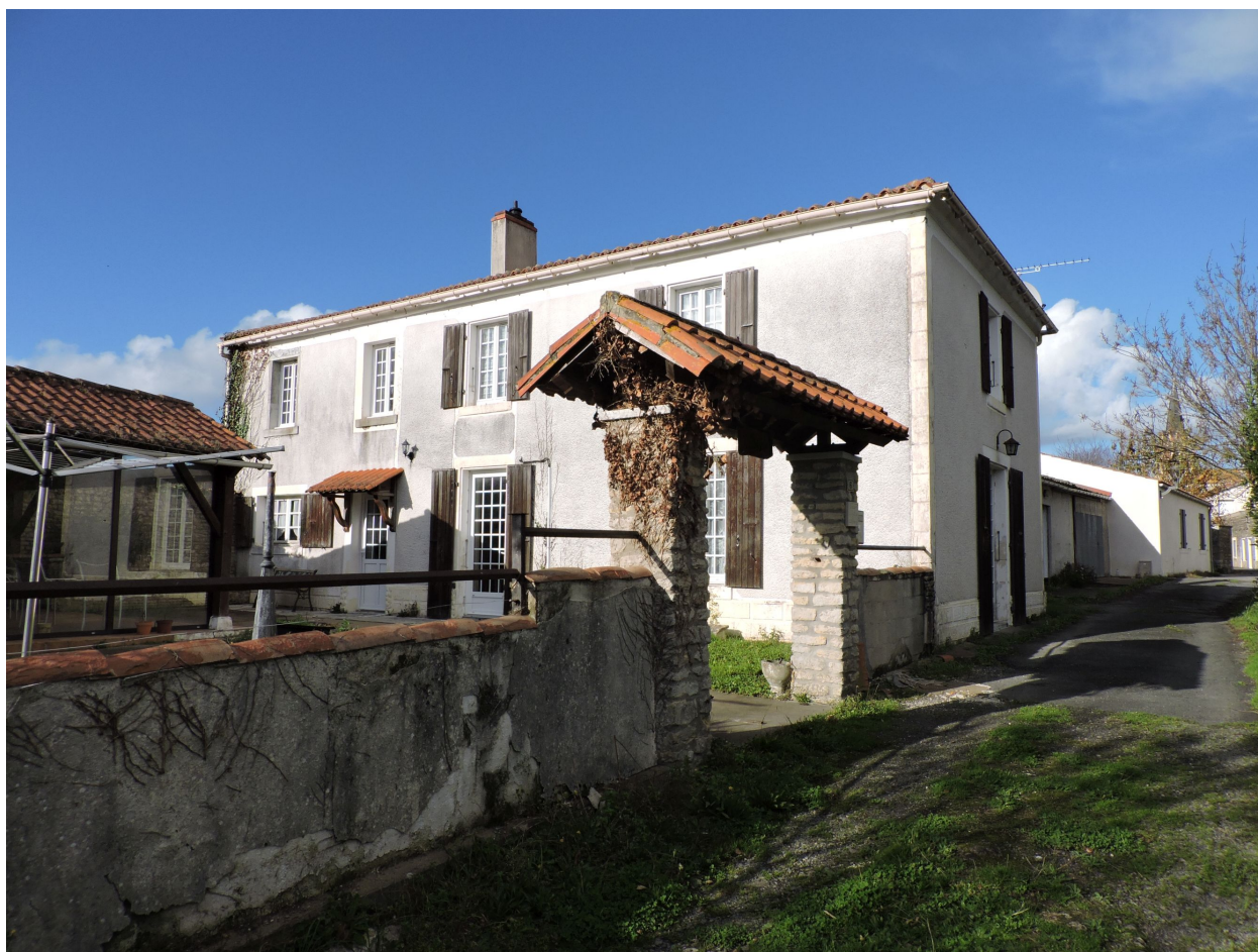
Vue depuis le sud.
