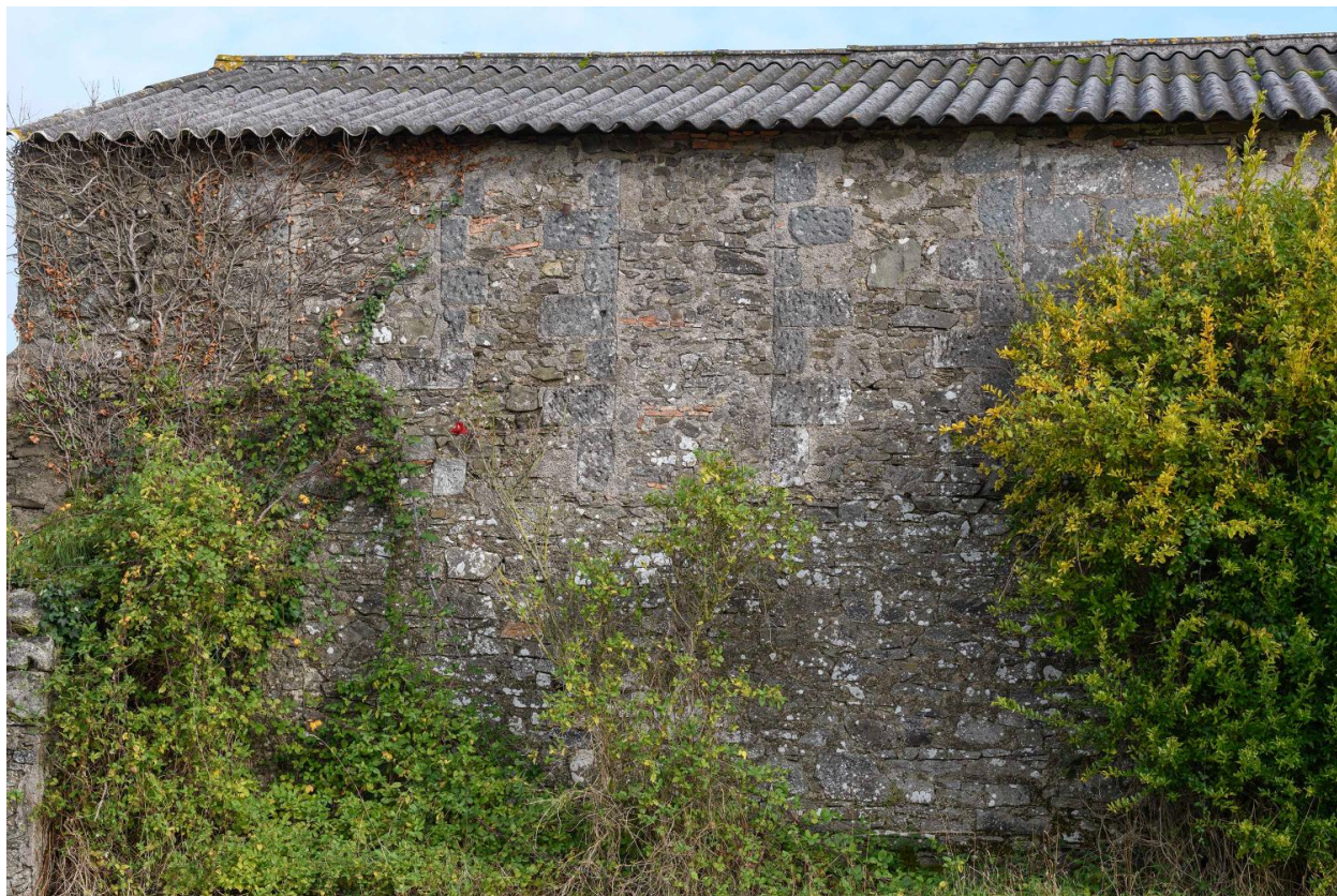
Détail des baies comblées de la façade sud, bâtiment ouest.
