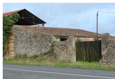
Vue du portail, partie ouest. Phot. Armelle Maugin IVR52_20244901020NUCA
