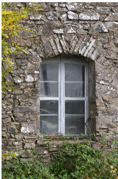
Détail d'une baie en moellons de micasciste, bâtiment ouest. Phot. Armelle Maugin IVR52_20244901017NUCA
