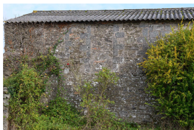
Détail des baies comblées de la façade sud, bâtiment ouest. Phot. Armelle Maugin IVR52_20244901019NUCA
