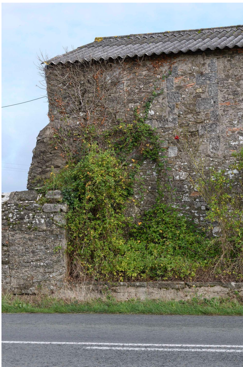
Détail d'un contrefort au sud, bâtiment ouest.
