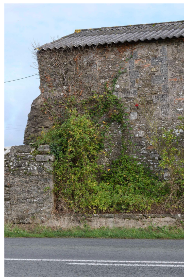
Détail d'un contrefort au sud, bâtiment ouest. Phot. Armelle Maugin IVR52_20244901016NUCA
