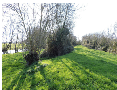
La digue provenant des terres hautes de la Grande Bernegoue, avec la Vieille Autise à gauche, en direction du sud-ouest. Phot. Yannis Suire IVR52_20218500966NUCA
