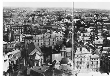
Vue aérienne de l'ensemble du pensionnat avec la chapelle, depuis la tour Saint-Aubin située au sud, photogr., [v. 1900]. Repro. François Lasa IVR52_19984902560X
