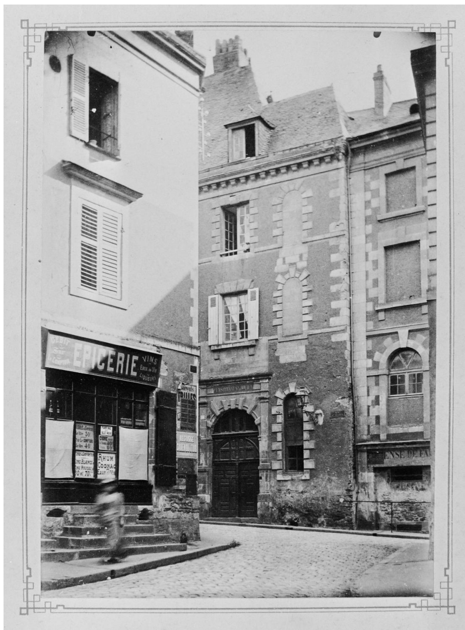
St Julien, rue St Denis et St Julien - Porterie démolie en 1892 - démolition générale en 1908, fotogr., [v. 1892].
