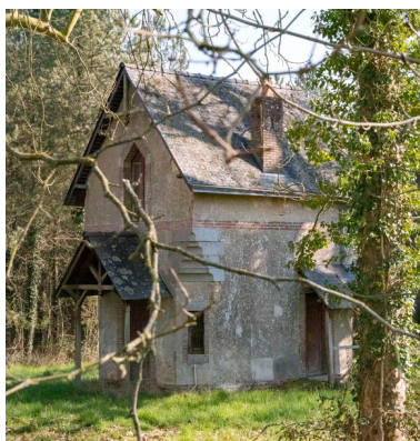
La maison de gardien. Phot. Pierre-Bernard Fourny IVR52_20235300112NUCA
