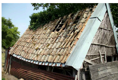
Petite loge en bruyère couverte de tuiles courbes. Phot. Jean-Baptiste Darrasse IVR52_20067206224NUCA
