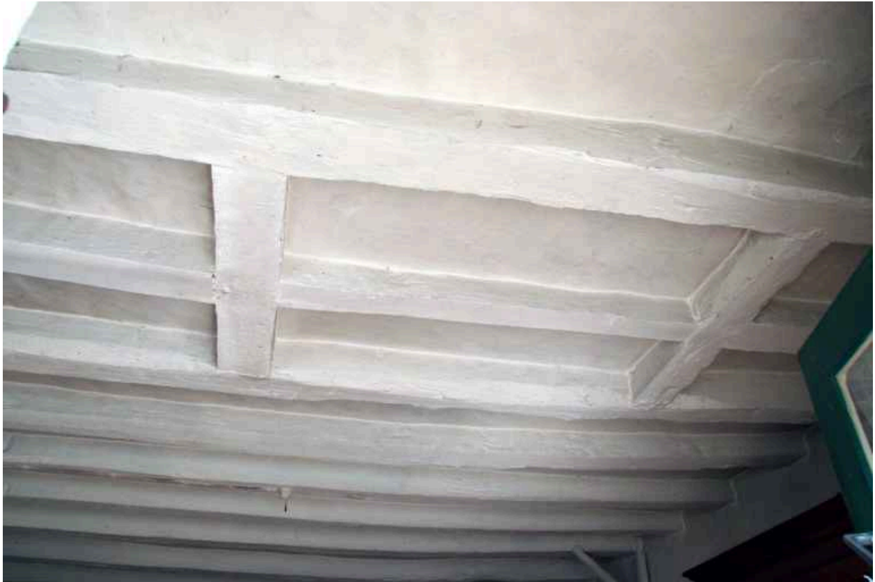
Maison n°1 : plafond de la salle.
