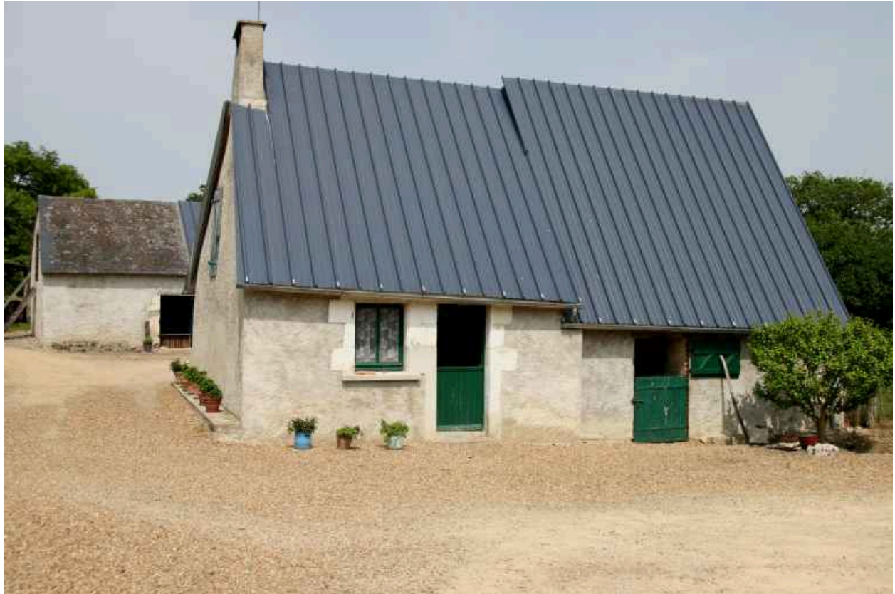
Maison n°1 : façade antérieure.
