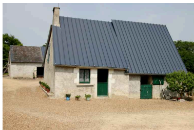
Maison n°1 : façade antérieure. Phot. Jean-Baptiste Darrasse IVR52_20067206221NUCA
