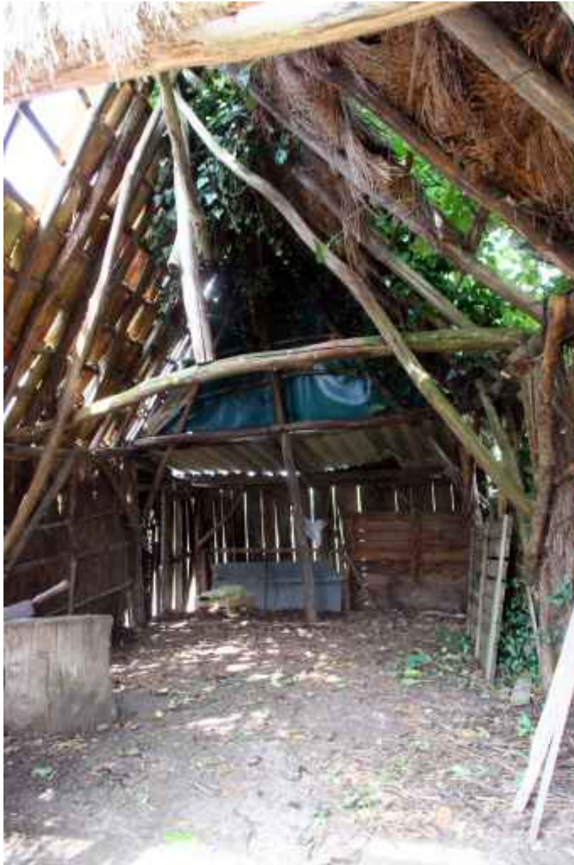
La petite loge en bruyère : mise en œuvre intérieure.
