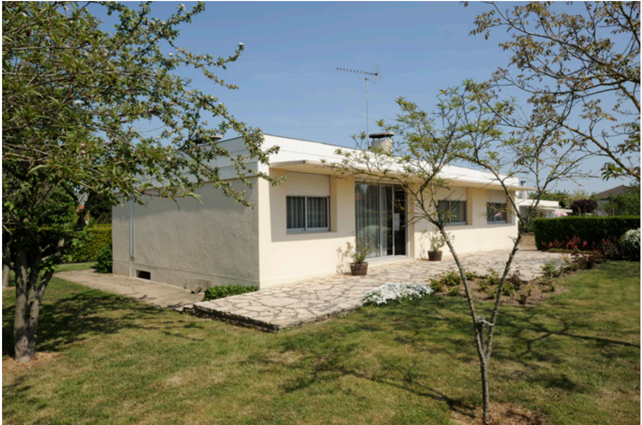
Maison du lotissement Bel Air, prise depuis le sud-est.
