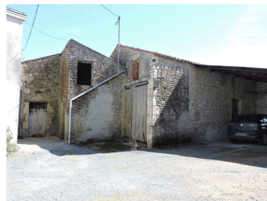
Les dépendances au sud de la cour, vues depuis le nord-ouest. Phot. Yannis Suire IVR52_20198501370NUCA
