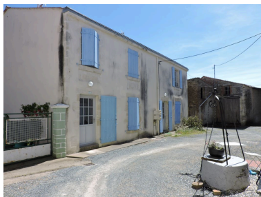
La cour commune vue depuis le nord. Phot. Yannis Suire IVR52_20198501296NUCA
