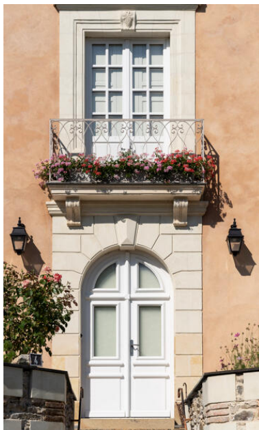
La travée centrale. Phot. Thierry Seldubuisson IVR52_20225300854NUCA
