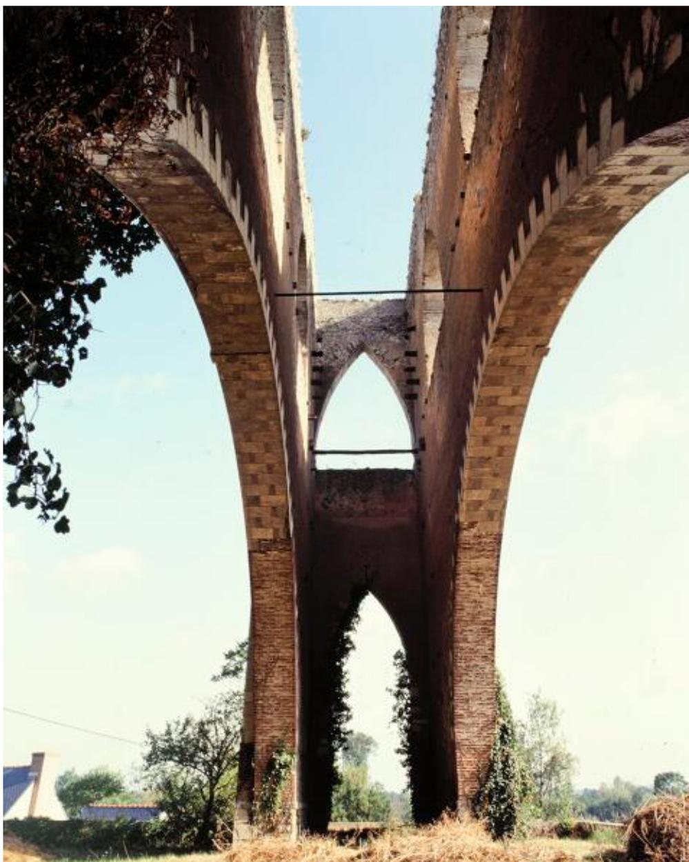
Détail de la structure du chevalement du puits de la Tranchée, fours à chaux de la Tranchée, Montjean-sur-Loire.
