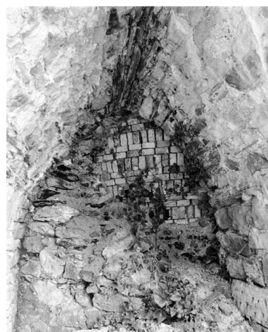
Robe du four obstruant la porte de défournement de l'ébrasoire sud-est, massif du four, partie est, fours de la Tranchée, Montjean-sur-Loire.
