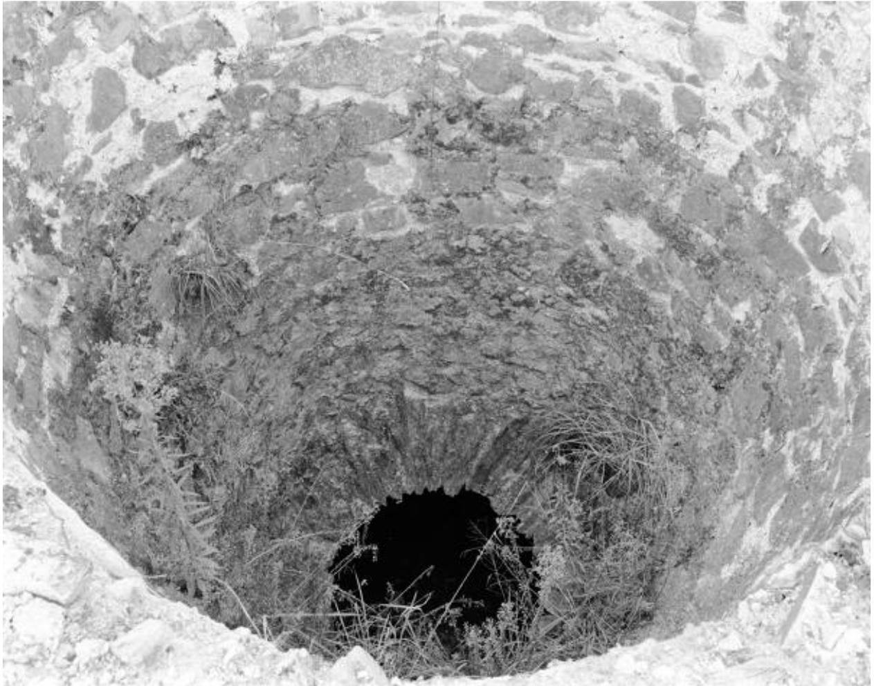
Vue de haut en bas d'un "entonnnoir" débouchant dans la grande galerie transversale dans la partie supérieure du massif des fours, fours à chaux de la Tranchée, Montjean-sur-Loire.
