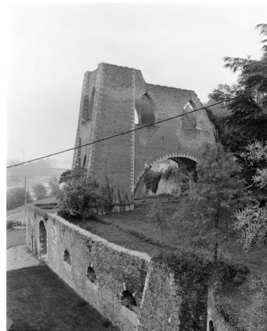
Au premier plan, mur de soutènement de la première terrasse et magasin à chaux comblé, au second plan, chevalement du puits de la Tranchée, fours de la Tranchée, Montjean-sur-Loire.
