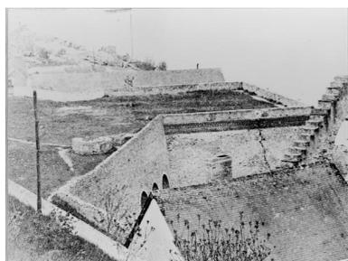
Plate-forme supérieure du massif des fours avant la destruction de la corniche. Détail d'une vue générale du site des fours à chaux de la Tranchée de Montjean-sur-Loire. Photographie vers 1920, C1, Valentin Laroute, collection privée de Maurice Chrétien.
