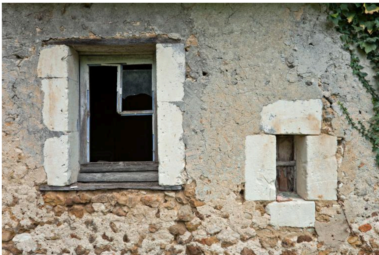
Façade antérieure : baies de la chambre froide.
