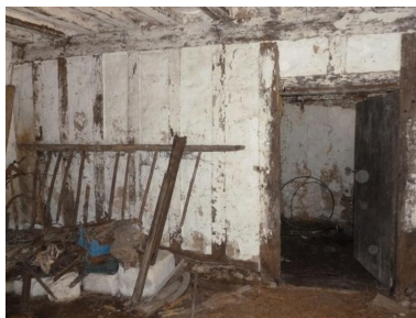
D tail de la chambre   feu : cloison en pan de bois. Phot. St phanie Aquilon IVR52_20117201681NUCA
