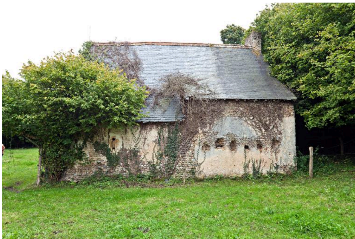
Façade postérieure aveugle.
