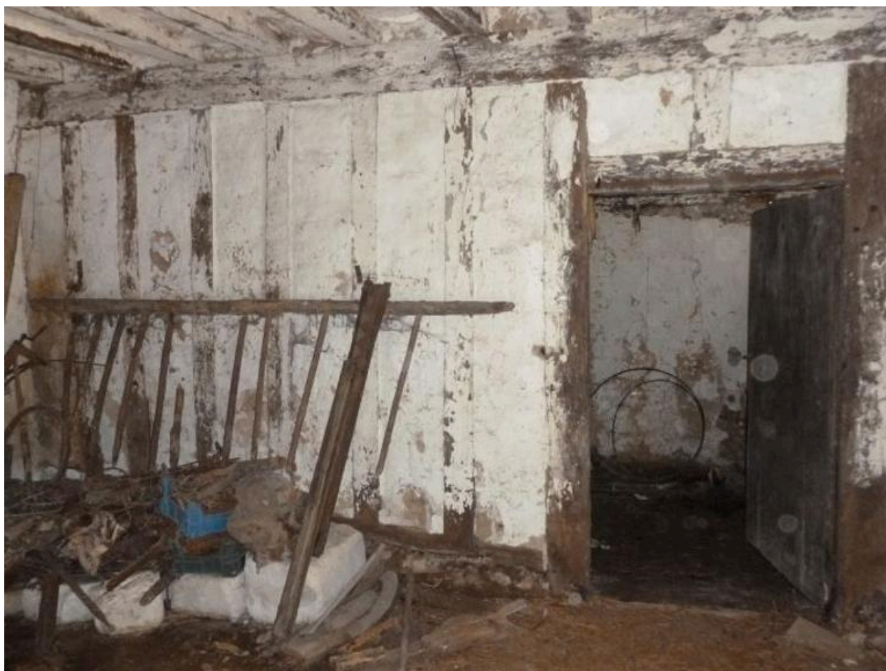
Détail de la chambre à feu : cloison en pan de bois.
