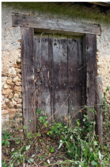
Fa ade ant rieure : porte d'entr e sur la chambre   feu, encadr e de bois. Phot. Yves Guillotin IVR52_20117200439NUCA
