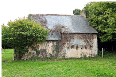
Façade postérieure aveugle. Phot. Yves Guillotin IVR52_20117200435NUCA
