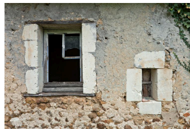
Fa ade ant rieure : baies de la chambre froide. Phot. Yves Guillotin IVR52_20117200437NUCA
