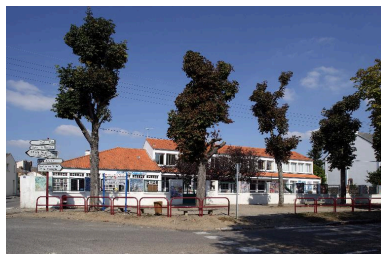
L'école maternelle Jacques Prévert vue depuis le boulevard. Phot. François Lasa IVR52_20054401420NUCA
