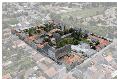
Vue aérienne de l'îlot, 2010. Phot. Élodie Rama IVR52_20104402755NUCA
