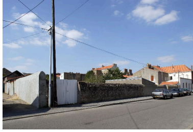
La façade Est de l'îlot depuis la rue Florent-Gariou (moitié nord). Phot. François Lasa IVR52_20054401424NUCA
