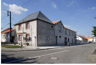
La façade Est de l'îlot depuis la rue Florent-Gariou, à l'angle, l'ancien hôtel de la gare. Phot. François Lasa IVR52_20054401425NUCA
