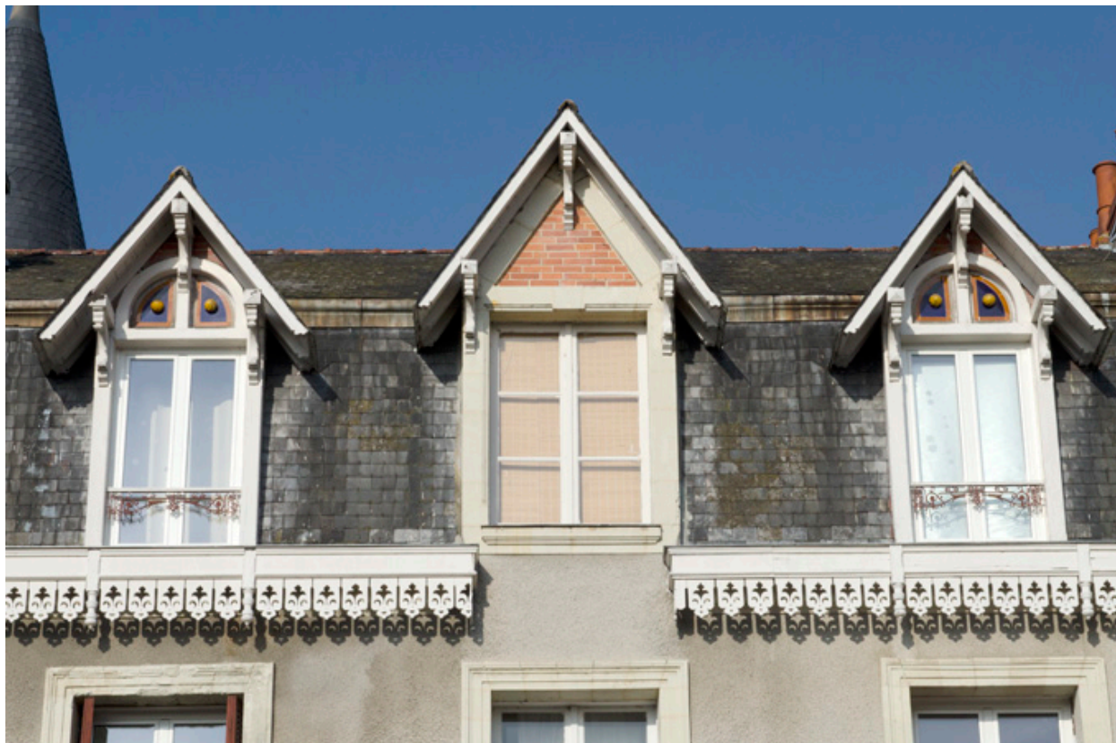
Détail des lucarnes à ferme débordante de la façade est.
