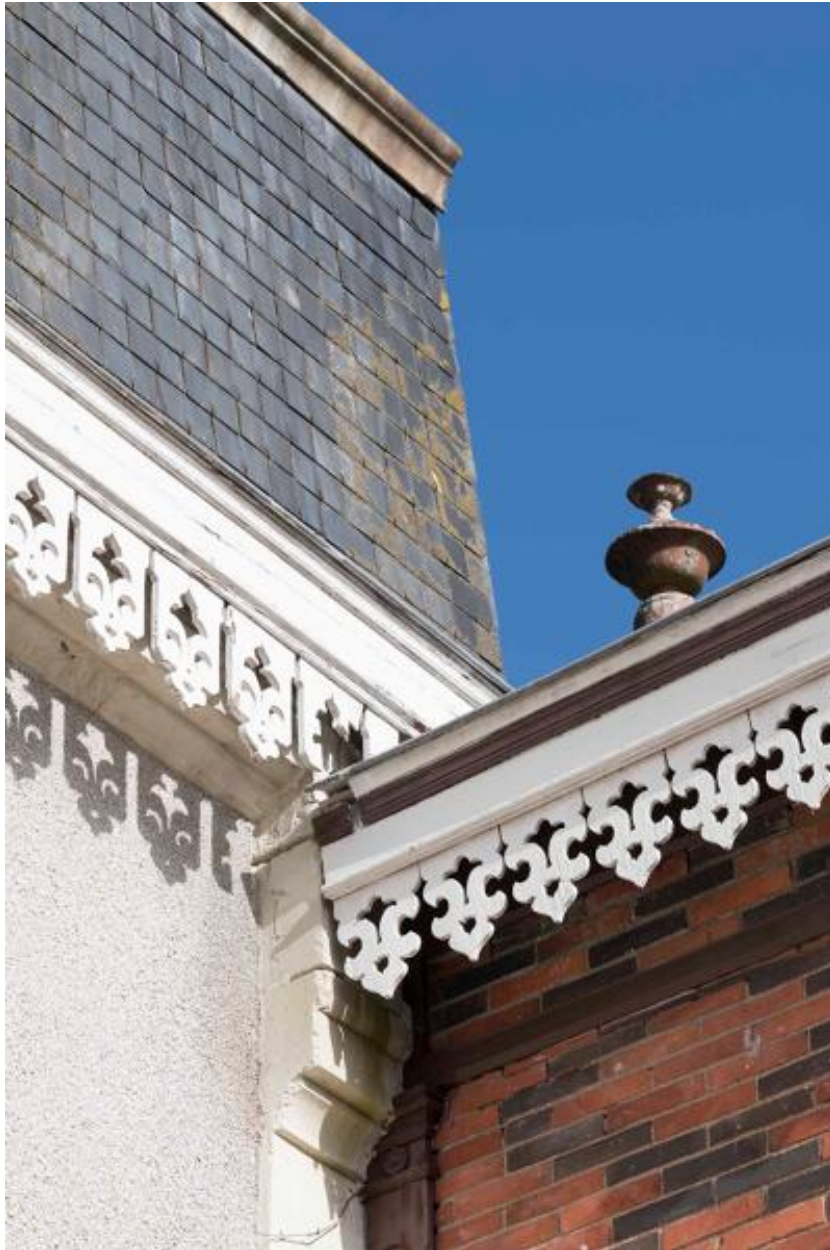
Façade est. Détails des lambrequins.
