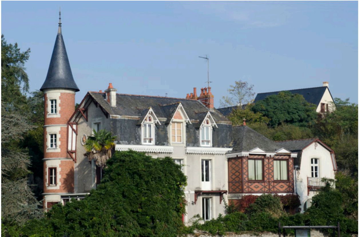
Vue depuis le sud-est.
