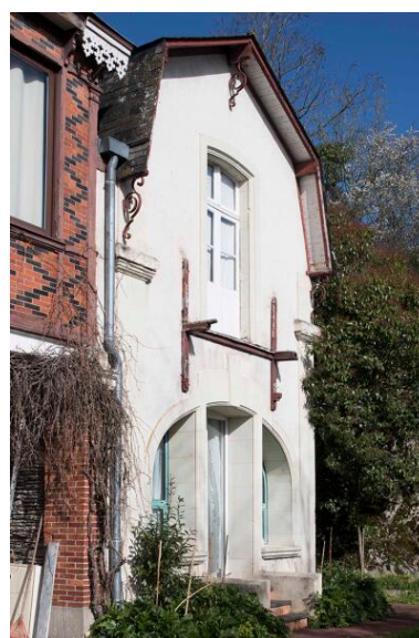
Détail de la façade (partie nord). Phot. Armelle Maugin IVR52_20194900113NUCA
