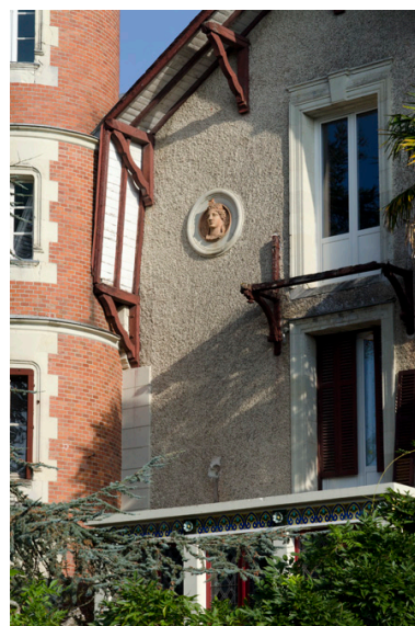
Pignon sud. Détail. Phot. Bruno Rousseau IVR52_20134901552NUCA
