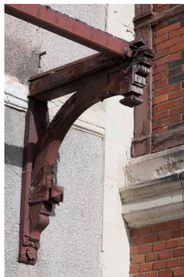
Façade est. Vestige de l'ancien balcon en bois. Phot. Armelle Maugin IVR52_20194900103NUCA
