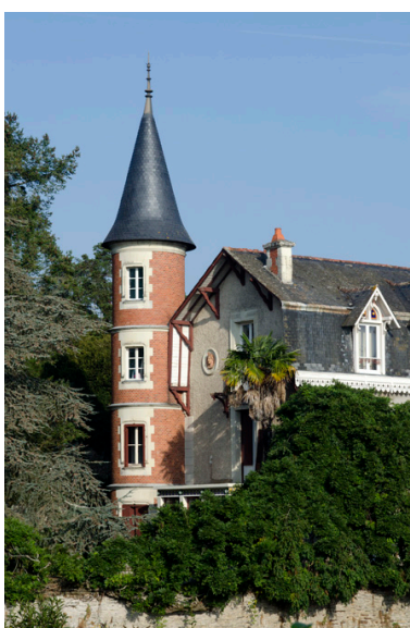
Détail de la tourelle d'angle. Phot. Bruno Rousseau IVR52_20134901550NUCA
