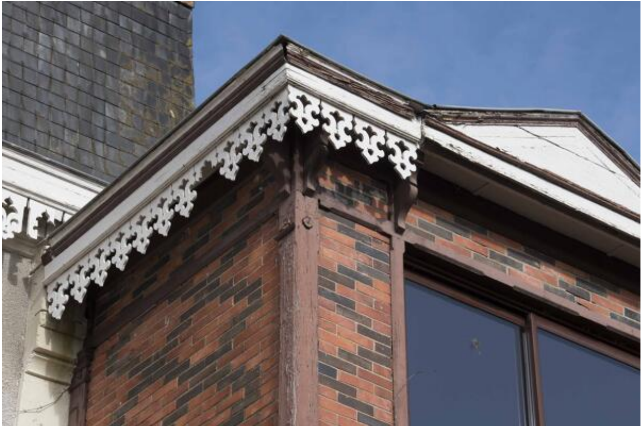
Façade est. Détails des lambrequins.
