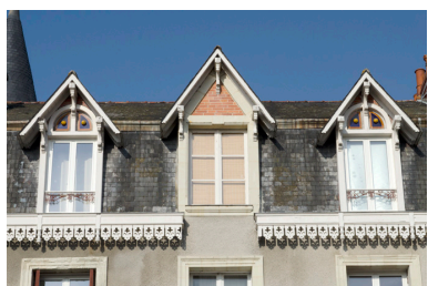
Détail des lucarnes à ferme débordante de la façade est. Phot. Bruno Rousseau IVR52_20134901553NUCA
