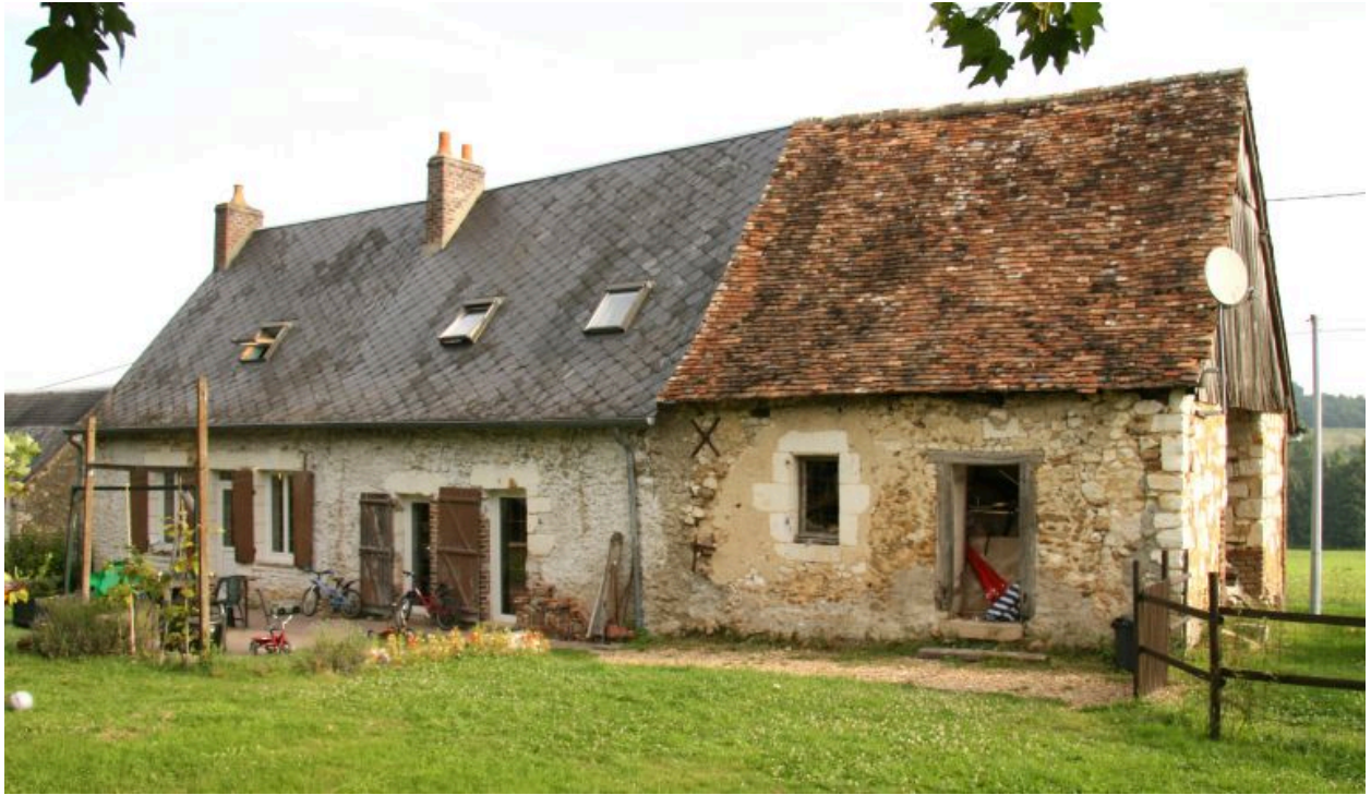
Maison 1 : façade sur la cour.
