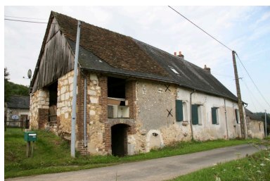
Maison 1, façade sur le chemin : bâtiment tronqué ou rallongé avec chaînages de briques. Phot. Jean-Baptiste Darrasse IVR52_20077201534NUCA
