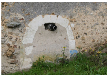
Maison 1, façade sur le chemin : entrée de cave. Phot. Jean-Baptiste Darrasse IVR52_20077201535NUCA
