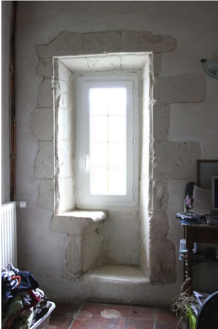
Maison 1, demi-baie à coussiège.
