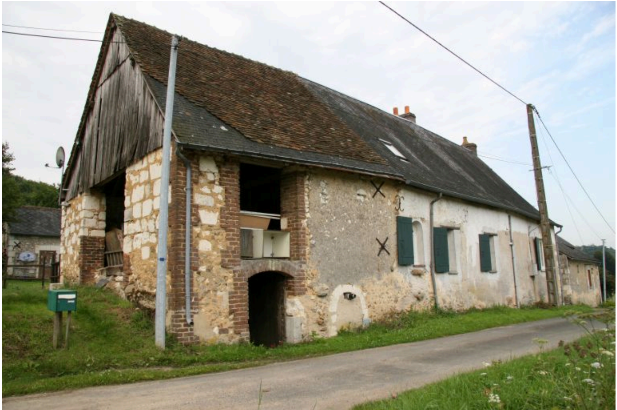
Maison 1, façade sur le chemin : bâtiment tronqué ou rallongé avec chaînages de briques.
