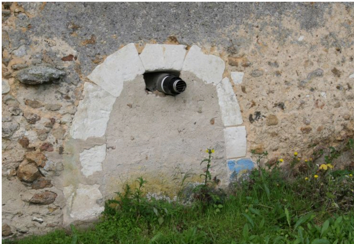
Maison 1, façade sur le chemin : entrée de cave.
