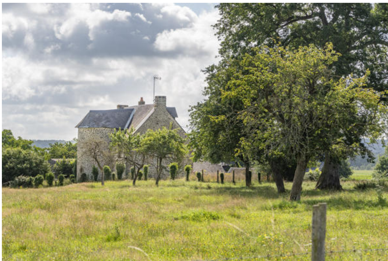
Une vue d'ensemble de la maison.
