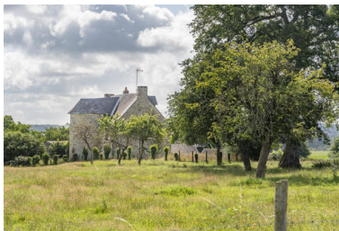
Une vue d'ensemble de la maison. Phot. Pierre-Bernard Fourny IVR52_20215300981NUCA
