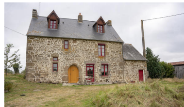
La façade antérieure de la maison. Phot. Pierre-Bernard Fourny IVR52_20215301048NUCA
