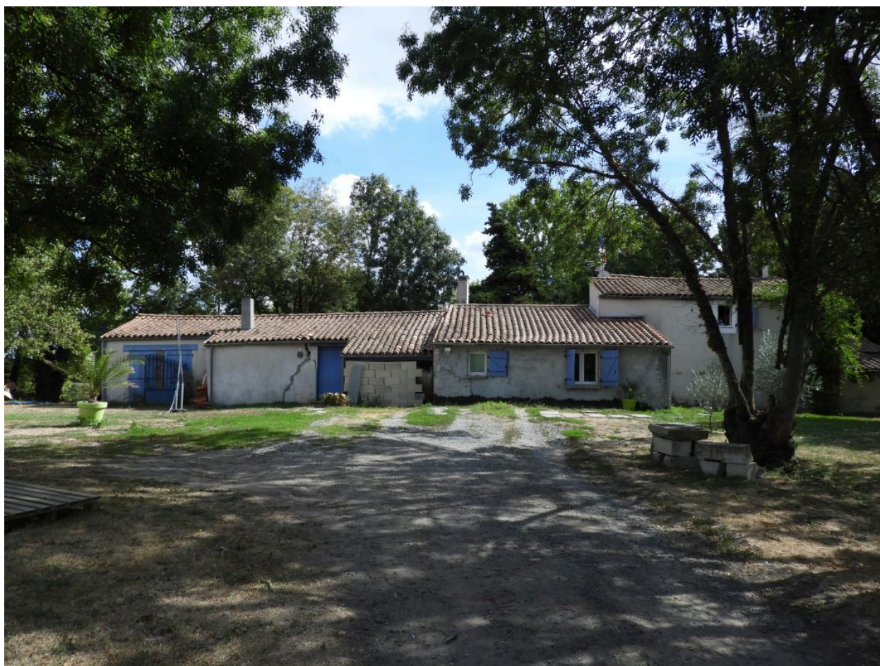
L'ancienne ferme vue depuis l'ouest, le logis à droite, les anciennes dépendances dans son prolongement à gauche.
