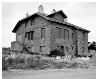
Elévation vue du sud-est. Phot. Denis Pillet IVR52_19984401584X
