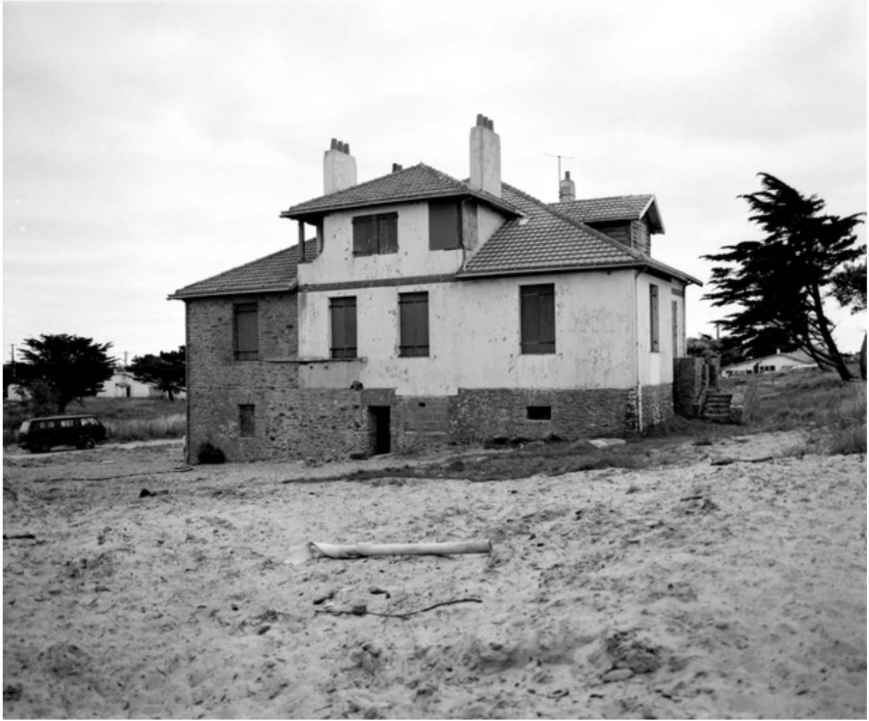
Elévation vue du sud-ouest.
