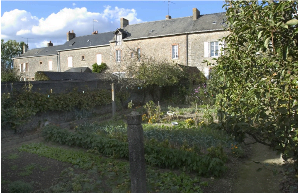
Vue arrière. La maison est la deuxième en partant de la droite.
