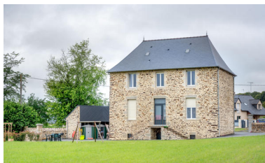
L'ancien presbytère, façade vers la vallée. Phot. Pierre-Bernard Fourny IVR52_20215300415NUCA
