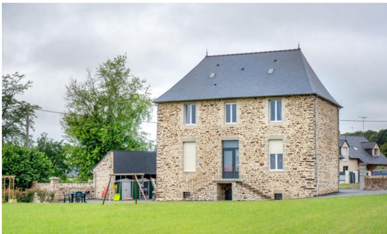
L'ancien presbytère, façade vers la vallée.
