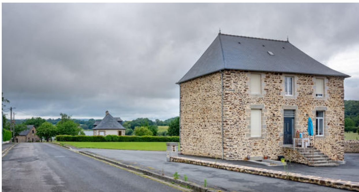
L'ancien presbytère, façade vers le bourg.
